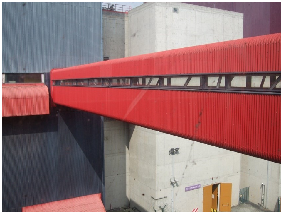
Figure 9 : Passerelle reliant la salle des machines à un bâtiment dans une centrale nucléaire française 14
