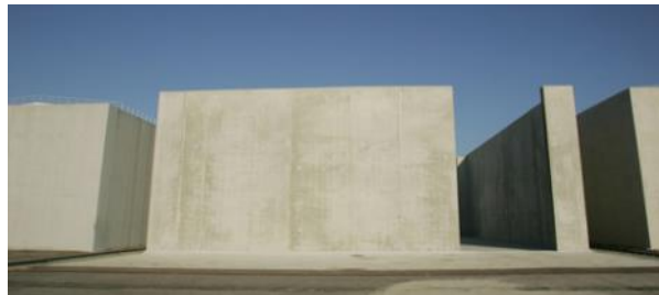
Alvéoles de stockage du CSA (P. Maurein, 2007)
