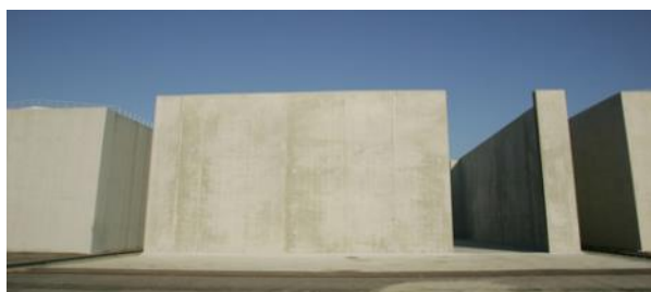
Alvéoles de stockage du CSA (P. Maurein, 2007)
