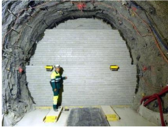
Mur de briques de bentonite remplissant une galerie du laboratoire souterrain (juillet 2012)
