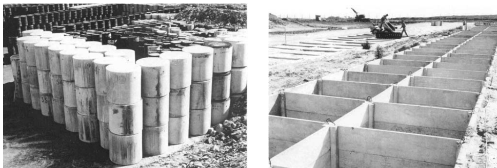
Plateforme de stockage (1971) et tranchées bétonnées (1969) (ANDRA)
