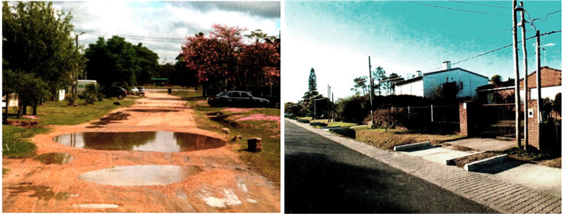
Imagen A1.15. Calles en Ciudad de la Costa: en Shangrilá luego de la lluvia (izq.) y en Solymar con saneamiento y evacuación de pluviales (der.)
