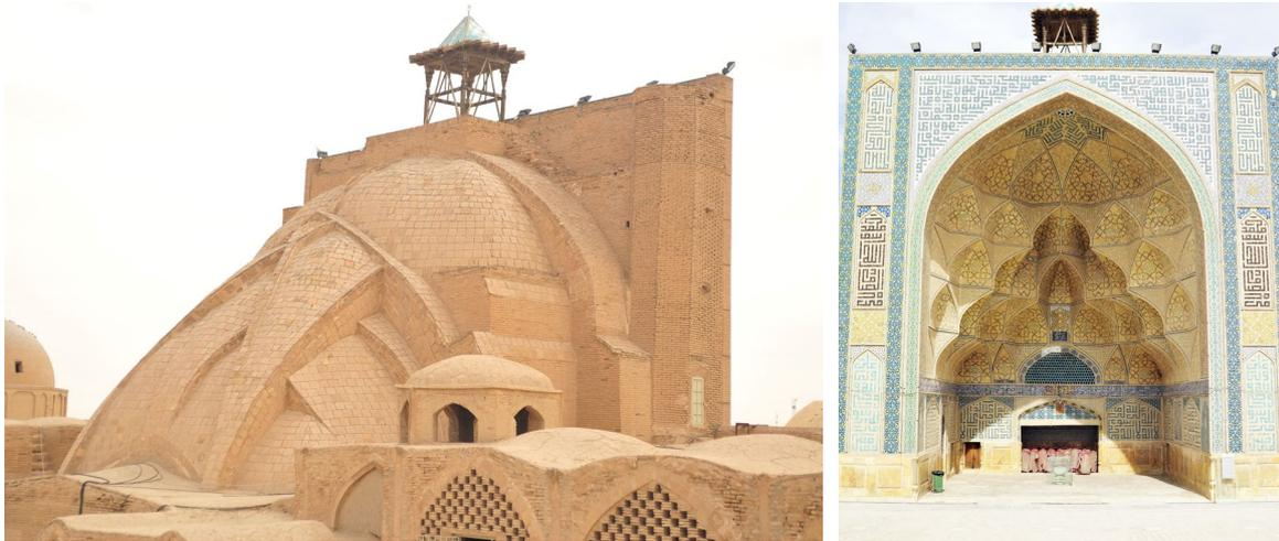
Figure 85. À gauche : extrados de l'iwan ouest de la grande mosquée d'Ispahan. À droite : intrados de l'iwan sud. Des « nervures » apparaissent sur l'extrados qui semblent refléter grossièrement la forme des Muqarnas de l'intrados. Nous voyons ici clairement une tentative de donner aux Muqarnas une fonction structurelle.
