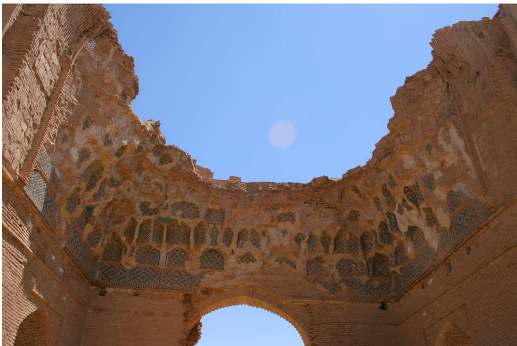
Figure 86. Mosquée de Zusan en Iran. L'état dégradé de l'édifice laisse voir la construction du Muqarnas ; il s'agit ici d'un Muqarnas autoporteur intégré à la voûte de l'iwan. Il n'y a pas d'élément de support pour le lier à la voûte © Alain Chassignoux.
