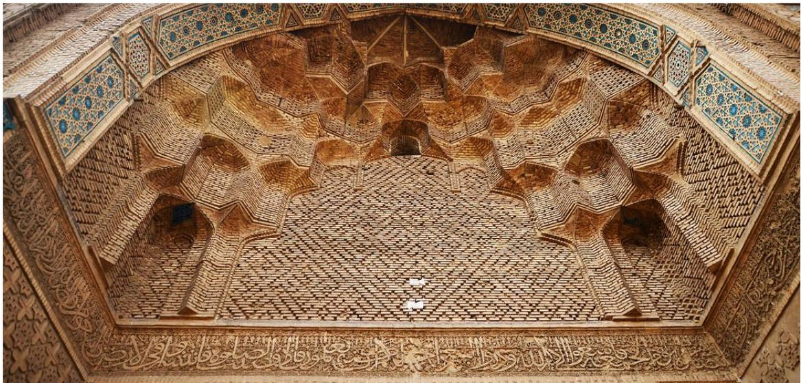
Figure 87. Photo du Muqarnas de la grande mosquée de Varāmin. La construction en brique montre clairement une construction par empilement et non suspendue © Ali Cheraghi.
