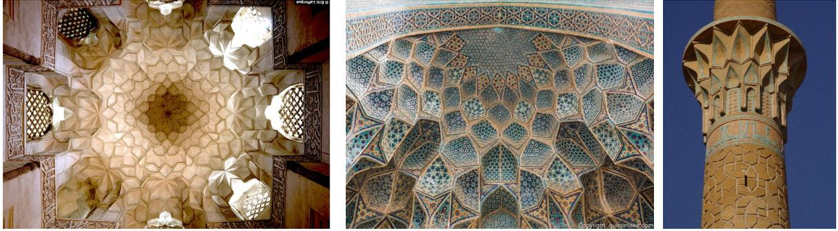
Figure 111. De gauche à droite : Muqarnas installé sur une coupole, une demi-coupole et un minaret.
