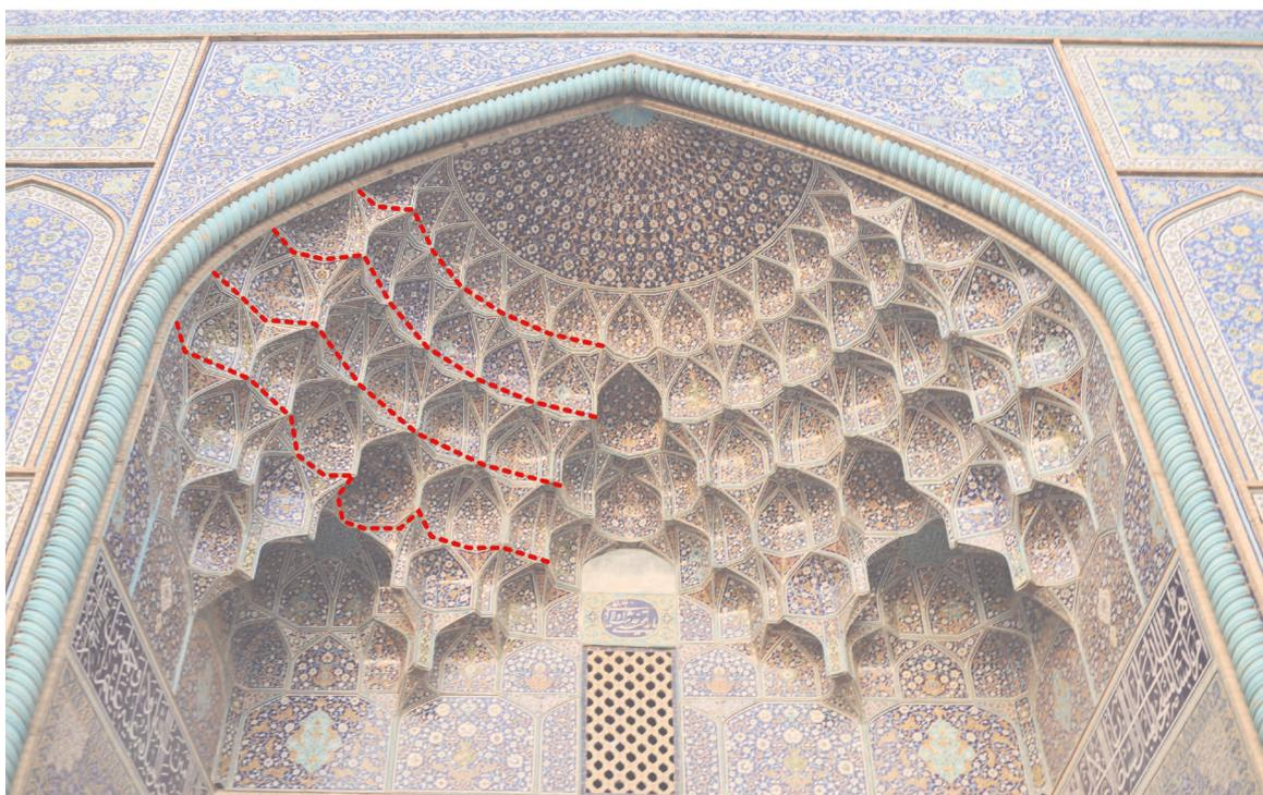
Figure 108. Organisation des cellules suivant des courbes de niveau.
