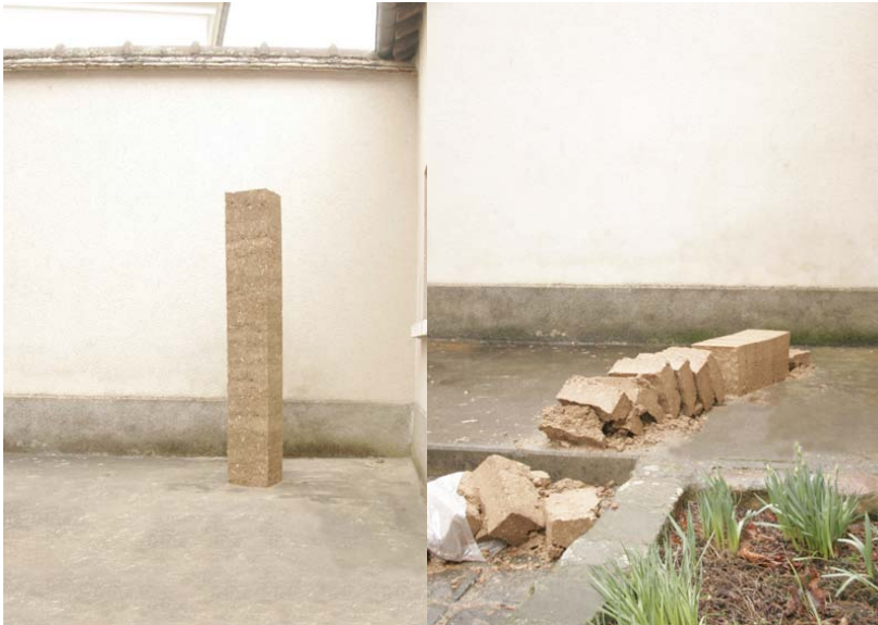
Pilier en pisé de terre cru d'Héricy et chute 27 février - 3 mars 2017
