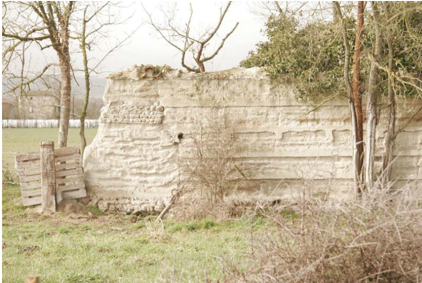
Ancien mur en pisé de terre crue dans les environs de Saint-Just- Saint-Rambert (Loire) Mars 2017
