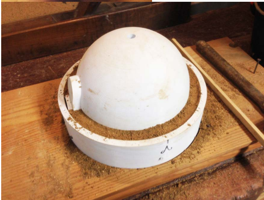
Construction du dôme en pisé
