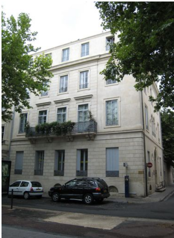
Fig. 142 – Angle Feuchères, 1, rue Jeanne d’Arc _ (photo de l’auteur)
