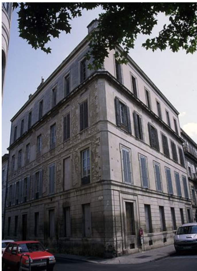
Fig. 136 – Maison d'angle rue Pradier et 5 av. Feuchères (photo de l'auteur)
