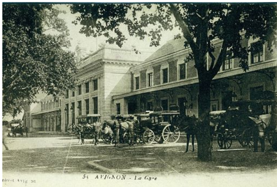
Fig. 217 - La gare reconstruite et agrandie au cours des années 1860 – cpa – (coll. de l'auteur)
