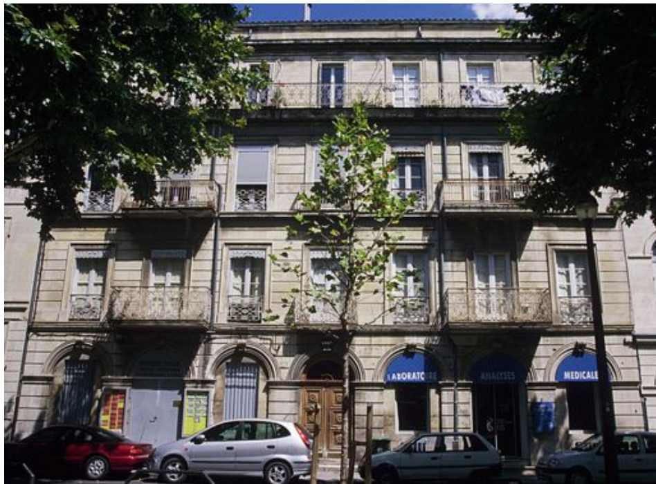
Fig. 137 – Maison 7 av. Feuchères - (photo de l'auteur)
