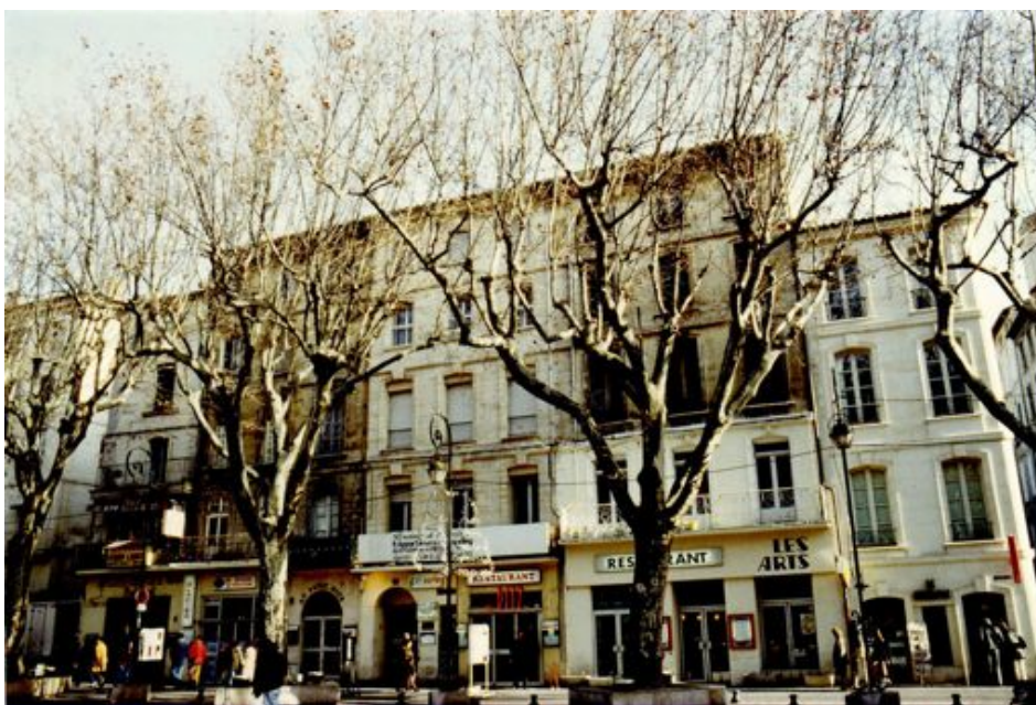
Fig. 195 – Façade est de la place de l'Horloge – (photo de l'auteur)
