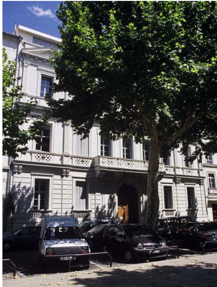
Fig. 138 - Maison 19, av. Feuchères - (photo de l'auteur)
