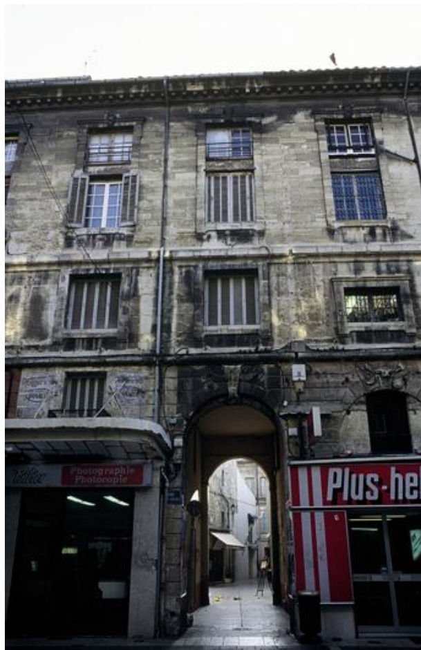
Fig. 167 - Vue de la Boucherie, rue du Vieux-Sextier (photographie de l'auteur)
