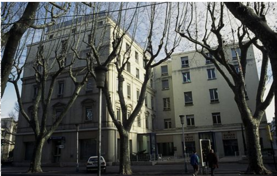
Fig. 250 - Banque Chaix, cours Jean-Jaurès – (Photographie de l'auteur)
