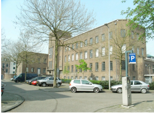
Le Lab (nord-ouest) espace culturelle et restaurant
