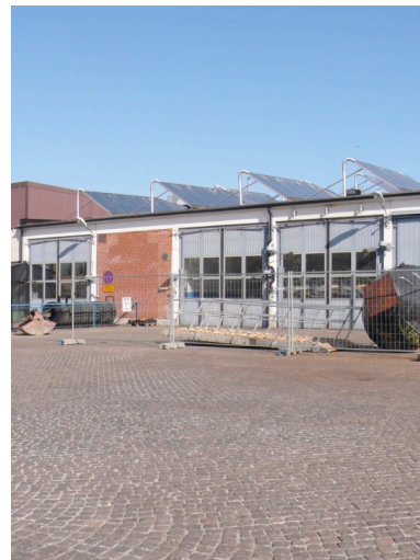
Panneaux photovoltaïques à Augustenborg – Source : Auteure, 2010
