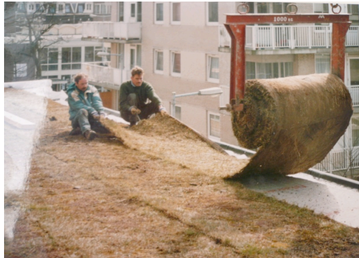
Pose des toitures végétalisées – Source : Photo de l'auteure, prise à partir d'une photo exposée lors de la fête des 25 du WGT
