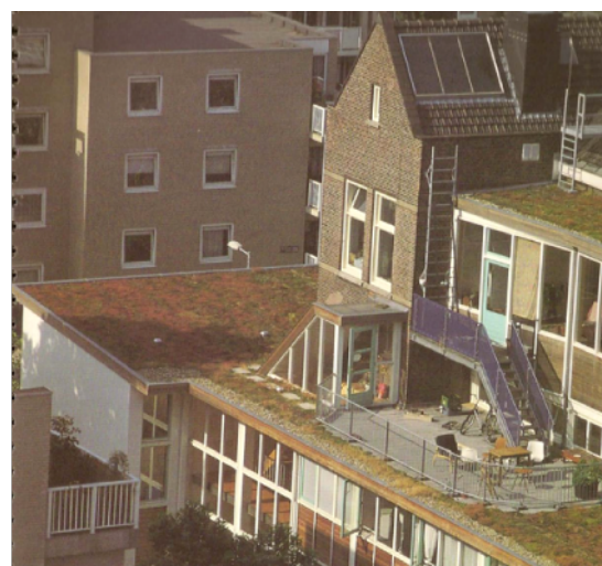
Toitures végétalisées et panneaux solaires installés dans le cadre de la rénovation des pavillons 1 et 2 du WGT – Source : WG, 1994, p. 36
