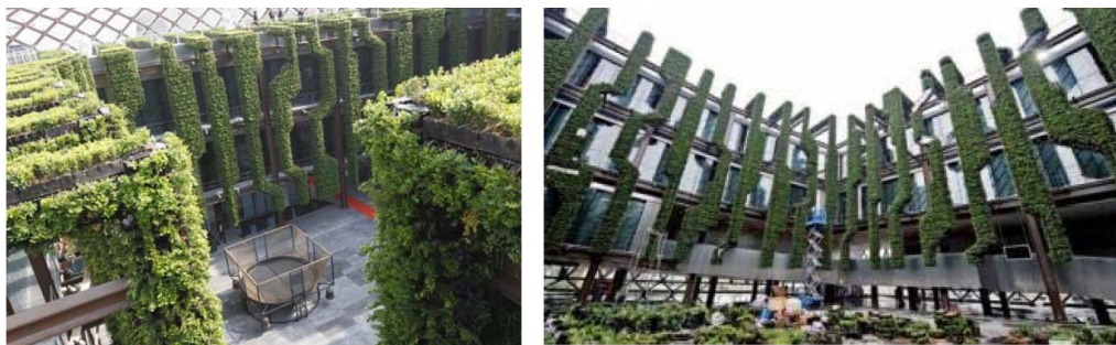
Vues interieures du Pavillon de France – Source : Google image 2011
