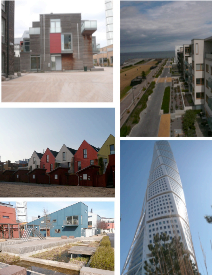
Architectures à Bo01 – Source : Auteure, 2010
