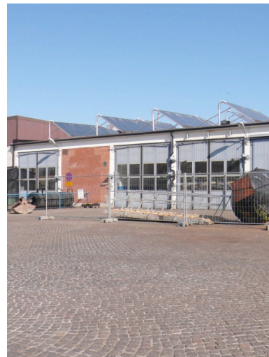
Panneaux photovoltaïques à Augustenborg – Source : Auteure, 2010
