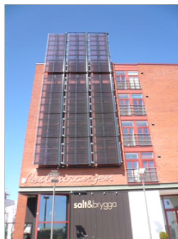
Photo : Façade en panneaux photovoltaïques à Bo01 – Source : Silvère Tribout, 2010
