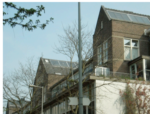
Panneaux photovoltaïques sur le toit des pavillons 1 et 2 – Source : Auteure, 2009
