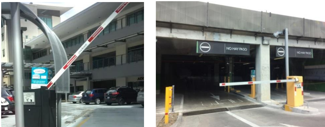
Figura 221. Sistema de garita y pago para acceder al estacionamiento en Avenida Escazú. Fuente: acervo de la autora (2018).
