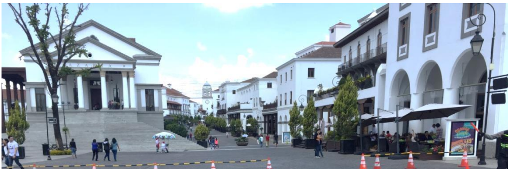
Figura 172. Ejemplos de técnicas de diseño y arquitecturas que apelan a la nostalgia o ciudades tradicionales peatonales. Arriba: Diseño de Krier mostrando las manzanas de construcción de tamaños diferentes alrededor de un centro o calle principal. Abajo: Vista de Paseo Cayalá similar a los bocetos de León Krier. Fuente: Krier (2007); acervo de la autora (2017).
