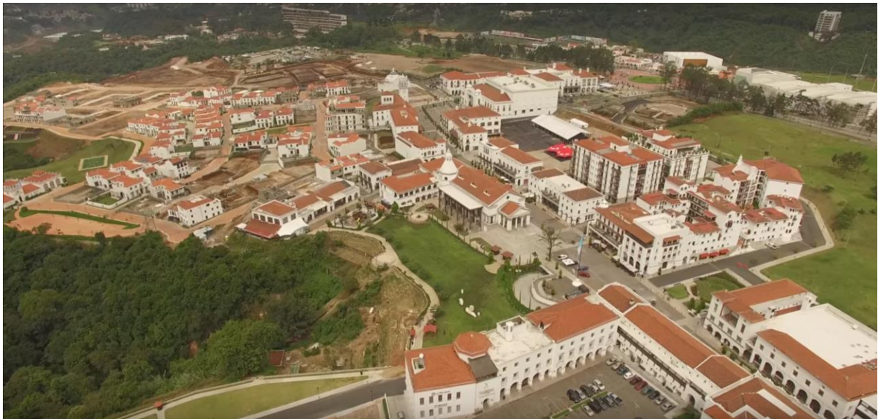
Figura 6. Vista aérea de Ciudad Cayalá en proceso de construcción en 2015. Fuente: Don Drone Guatemala (2015).
