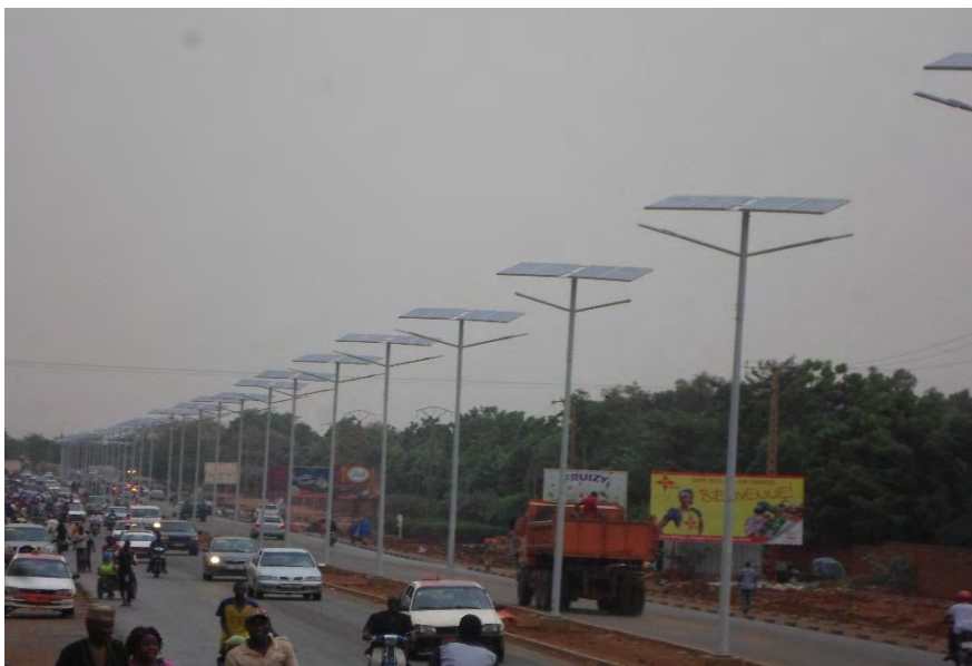
Photo 45 : Éclairage public par l'énergie solaire Source : Abdourazack N. A., 2018
