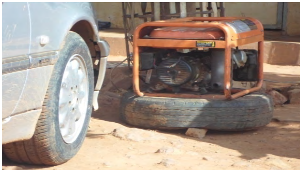
Photo 40 : Générateur de 15KVA utilisé par un ménage Source : Abdourazack N. A., 2018
