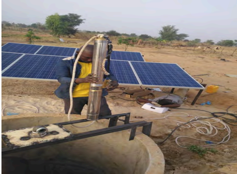
Photo 58 : Installation d'une pompe solaire dans un jardin de Niamey Source : Abdourazack N. A., 2018
