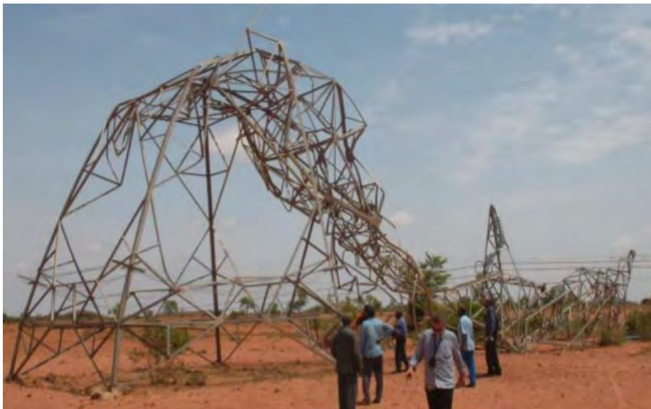
Photo 1: Pylône 612 Source : Mailele D. A., 2013
