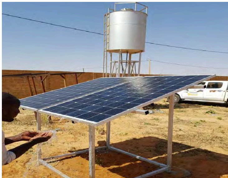
Photo 62 : Forage d'eau fonctionnant à l'énergie solaire dans la périphérie Niaméenne Source : Abdourazack N. A., 2018
