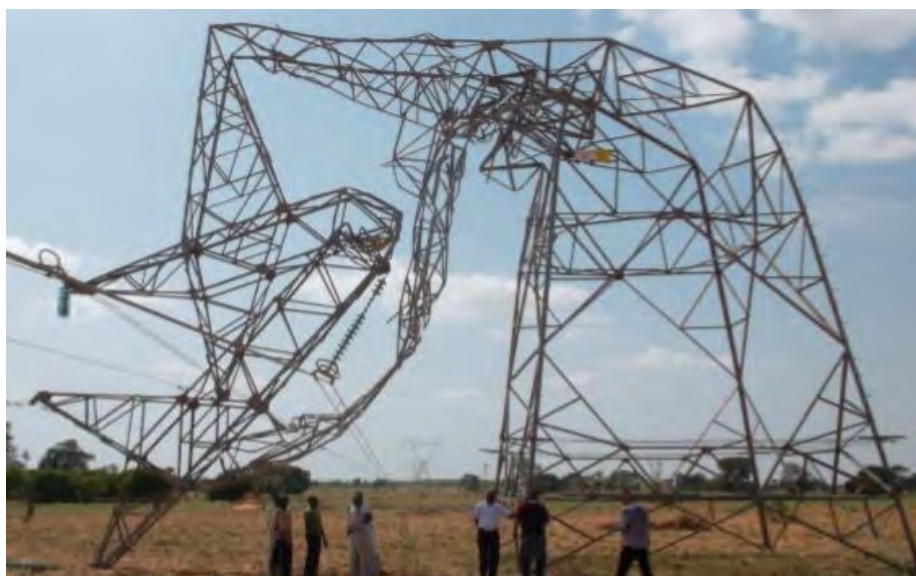
Photo 2 : pylône 620 Source : Mailele D. A., 2013
