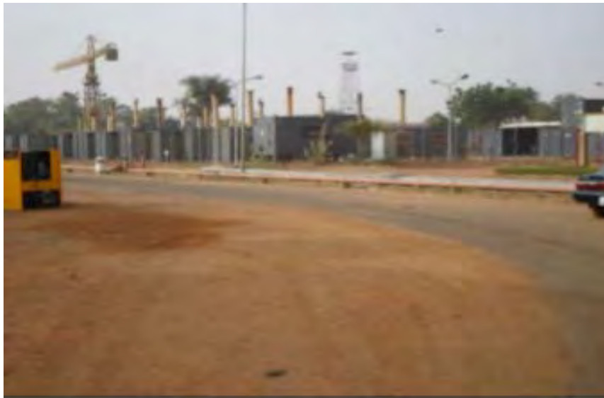
Photo 11 : Site de production électrique du groupe AGGREKO Source : NIGELEC, 2018
