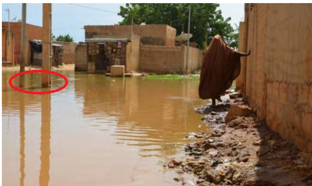
Photo 6 : Poteau électrique BT inondé par les eaux de pluies à Niamey Source : Jeune Afrique, publié le 16/09/2017 sur tribuneouest.com
