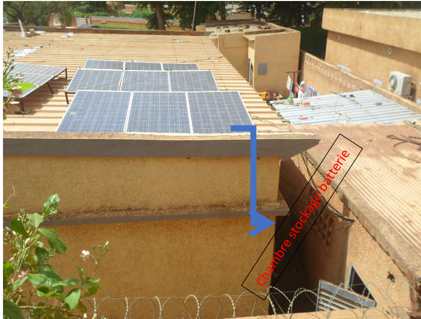
Photo 41 : Concession électrifiée à base de l'énergie solaire dans le quartier plateau Source : Abdourazack N. A., 2018
