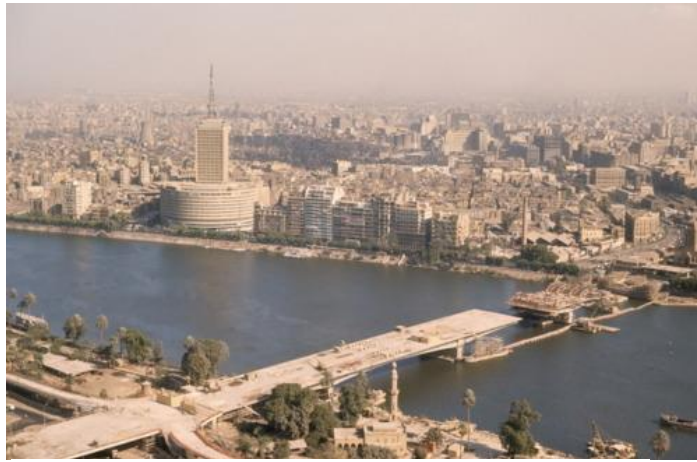
Figure 3.1.20. La construction du pont du 6 octobre.
