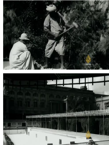
Figure 2.2.7. Démolition des clôtures de jardin du palais Abedin, 1956.
