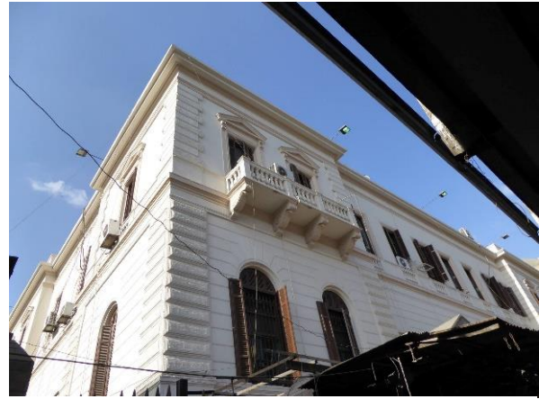
Figure 3.3.44. Le bâtiment de la Caisse de la dette caché derrière le pont d'al-Azhar.
