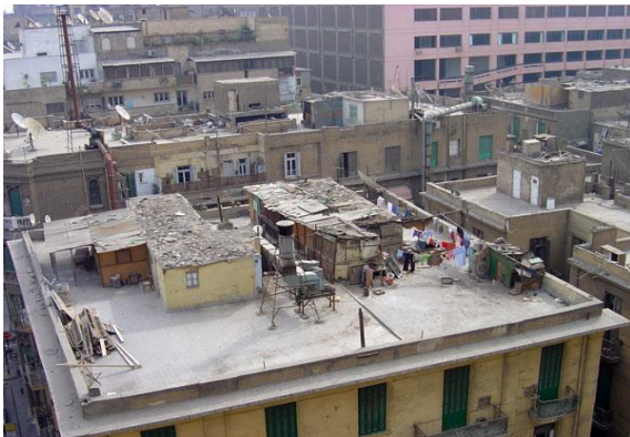
Figure 3.2.4. Ancienne buanderie habitée sur le toit d'un immeuble, quartier Bab El-Louk.
