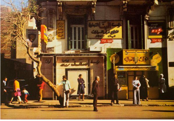
Figure 3.2.7. La dégradation des anciennes façades du centre-ville au début de 1973.
