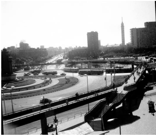
Figure 3.3.17. Le pont des piétons sur la place Tahrir.
