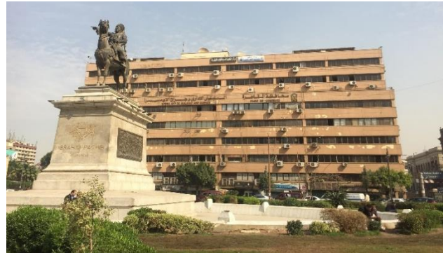
Figure 3.3.22. La place après l'installation du bâtiment du garage.
