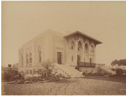
Figure 2.2.8. Villa Delort de Gléon, rue al-Chawarby.
