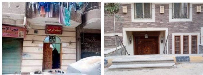
Figure 3.3.27-28. Les Zawyas au bas des immeubles au quartier al-Haram.
