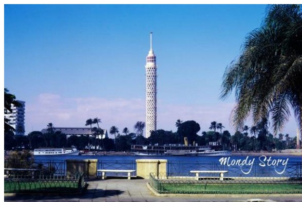
Figure 2.1.18. La Tour du Caire après la construction.
