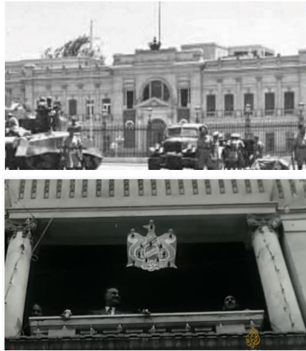
Figure 2.2.6. Remplacement de symbole du Trône de la monarchie par l'aigle de la république sur la façade du palais d'Abedin.
