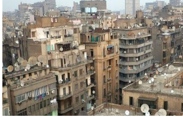
Figure 3.2.6. Appropriations et surélévations sur les toits de la rue Qasr al-Aini.
