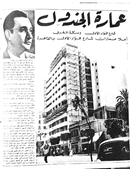
Figure 1.2.38. L'immeuble Gandoul sur l'avenue Fouad 1 er .
