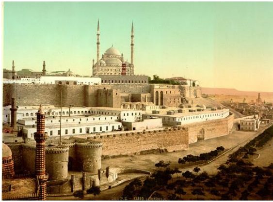
Figure 1.3.14. Les casernes britanniques à la citadelle.
