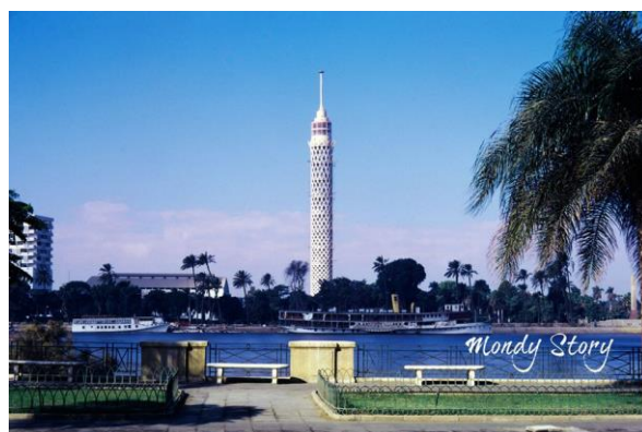
Figure 2.1.18. La Tour du Caire après la construction.
