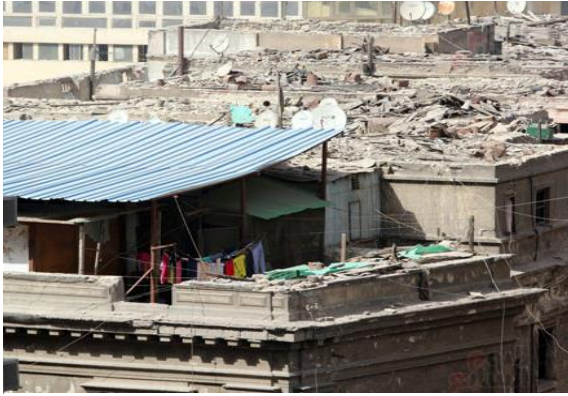
Figure 3.2.5. Appropriation d'un toit sur un immeuble au centre-ville.
