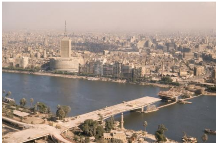
Figure 3.1.20. La construction du pont du 6 octobre.
