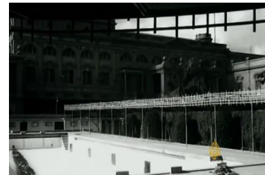
Figure 2.2.7. Démolition des clôtures de jardin du palais Abedin, 1956.
