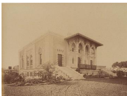
Figure 2.2.8. Villa Delort de Gléon, rue al-Chawarby.
