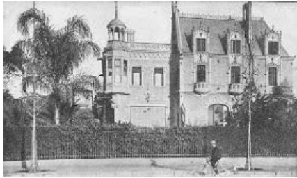
Figure 2.2.13. Villa Qout al-Qulub démolie en 1966.
