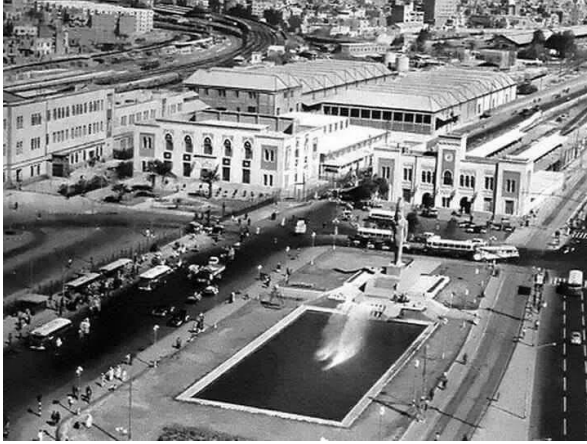
Figure 2.1.33. Place de la Gare après l'installation de la statue Ramsès II, 1954.
