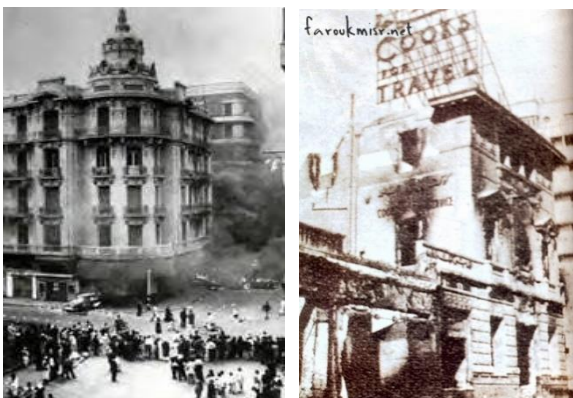
Figure 1.3.43. Différentes scènes de l'incendie dans la ville moderne.
