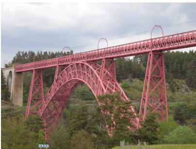
FIGURE 1.1 – Un exemple de treillis de poutres, le viaduc de Garabit. Achevé en 1884, le viaduc de Garabit est un ensemble de poutres en fer puddlé conçu par l'entreprise Eiffel.
