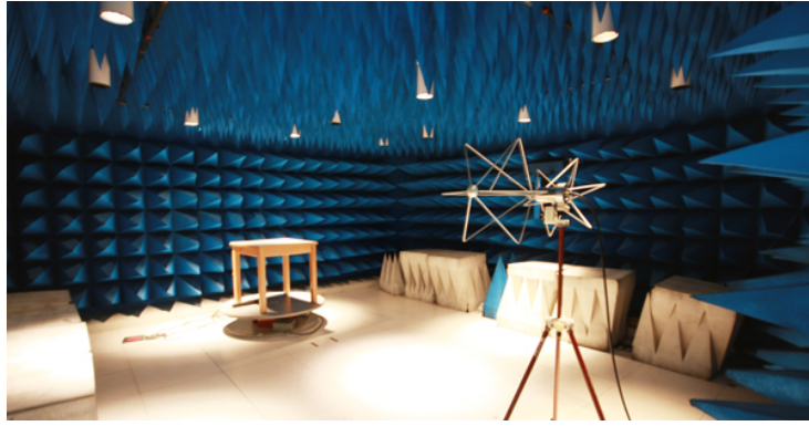
FIGURE 1.25 – Chambre en configuration semi-anéchoïque (IEMN)
