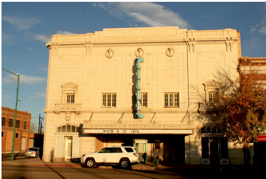
Photo 13. Grand Theatre de Douglas, autrefois très fréquenté, en rénovation depuis 2018 (C. Fortuné, Douglas, 2018)
