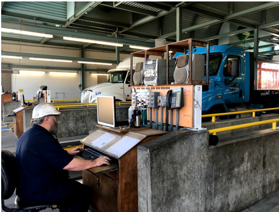
Photo 17. Des camions roulent sur une plateforme équipée d'une balance et de rayons X au PoE d'Otay Mesa. L'agent inspecte leurs poids sur son ordinateur pour s'assurer qu'ils ne transportent pas de drogues (C. Fortuné, San Diego, avril 2019)
