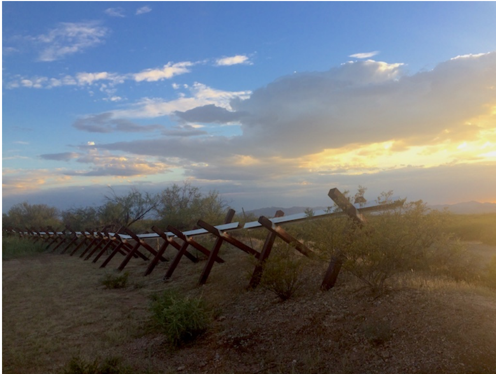
Photo 22. Barrières de véhicules à Douglas (C. Fortuné, Douglas, septembre 2017)
