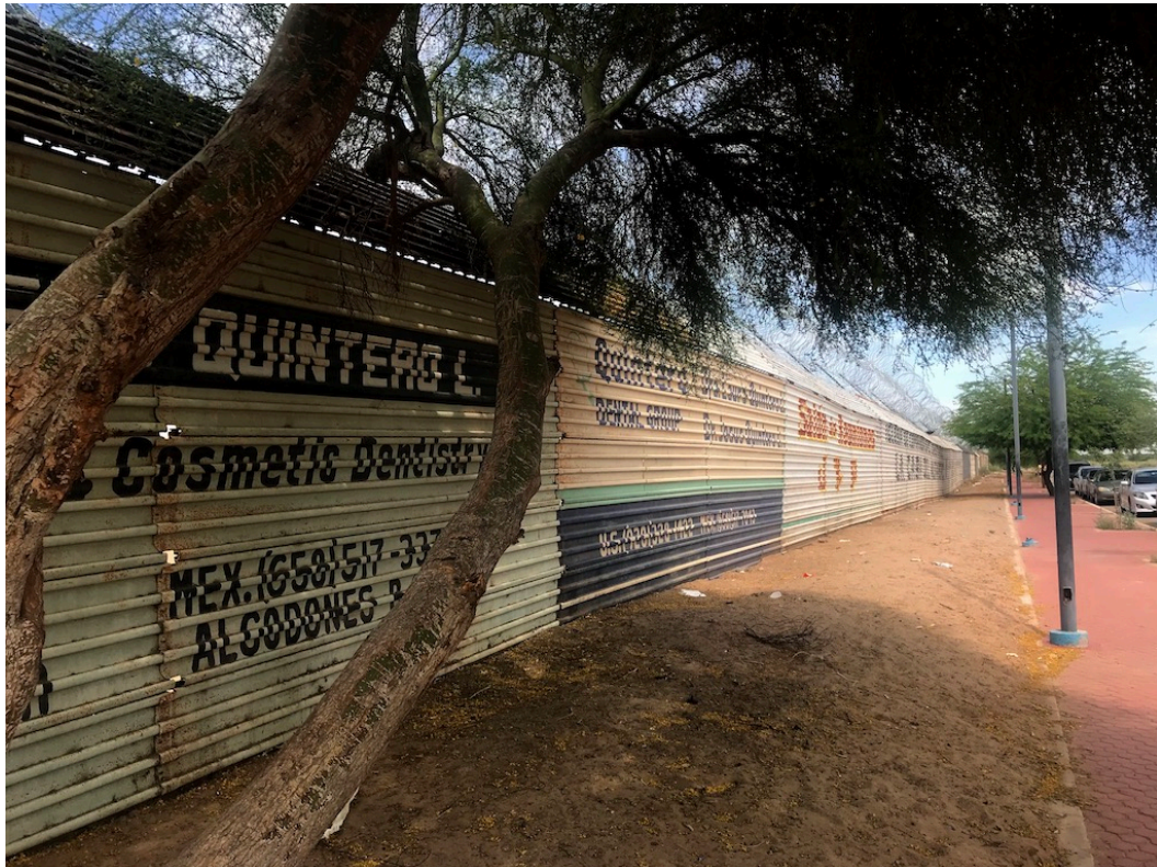
Photo 2. Barrière faite de plateformes d'atterrissage pour hélicoptères (C. Fortuné, Tecate, avril 2019)
