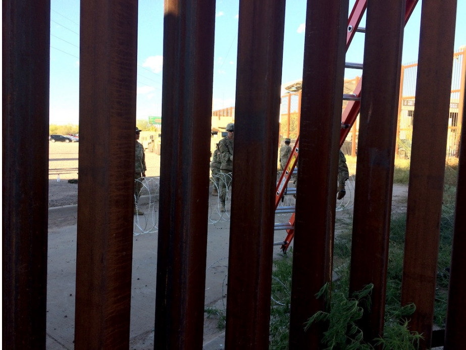
Photo 5. Militaires installant les fils barbelés le long de la barrière (C. Fortuné, Agua Prieta, novembre 2018)
