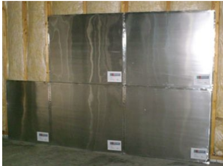
Figure 15. Panneaux Energain® appliqués sur un mur ( www.constructioncayola.com )
