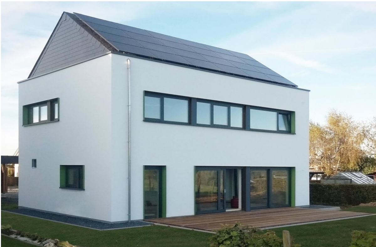
Figure 16. Vue sur la Living LabNcube ( www.construction21.org )
