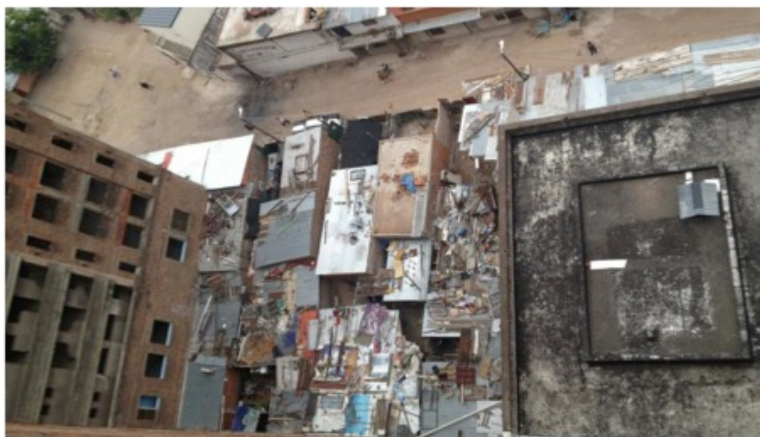
Figure 6-9 - Photographie prise depuis les étages supérieurs de El Elefante Blanco, montrant le développement d'un podium habité aux pieds de la structure, entre ses redents. Source : auteur, 2014
