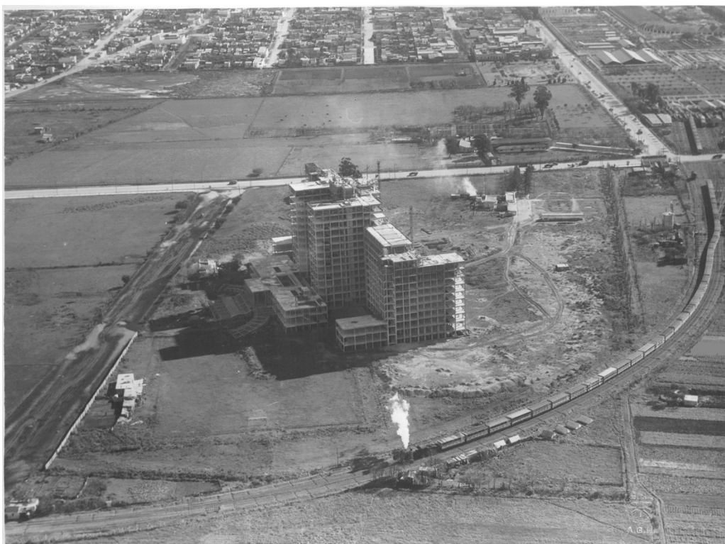
Figure 2-17 - Photographie aérienne prise lors du chantier de l'Institut contre la Tuberculose, Buenos Aires, 1938, Source : Archives Générales de la Nation, Inv. 184948-A, NEG / M.7748 C.447 Buenos Aires [Document consulté le 23 juillet 2014]
