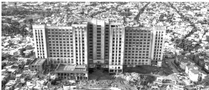
Structure : El Elefante Blanco Début du chantier : 1937 (arrêté puis repris sous Perón) Crédit : Mario Quinteros, Journal Clarin, (capture par drone), 2018
