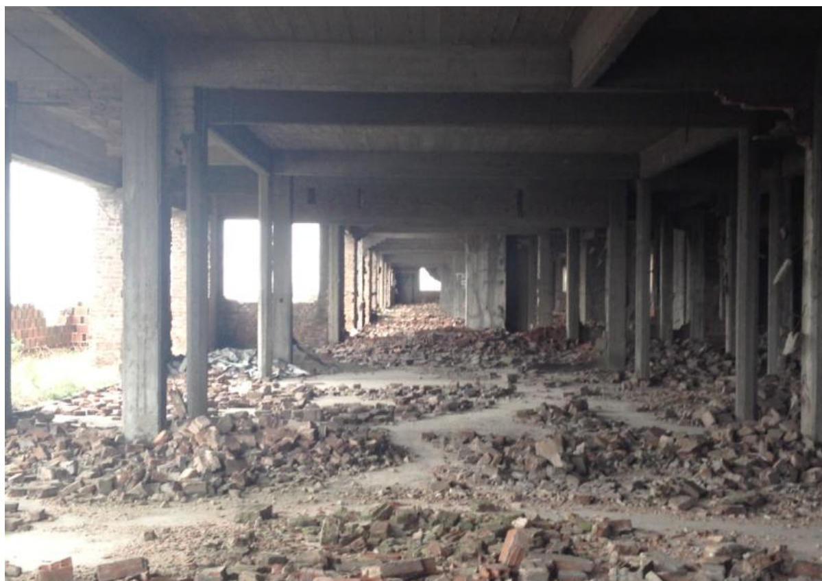
Figure 6-3 - Photographie prise au dixième étage de El Elefante Blanco. Les éléments de remplissage en brique ont été démolis pour être réemployés dans la construction de la Villa 15. Source : auteur, 2014
