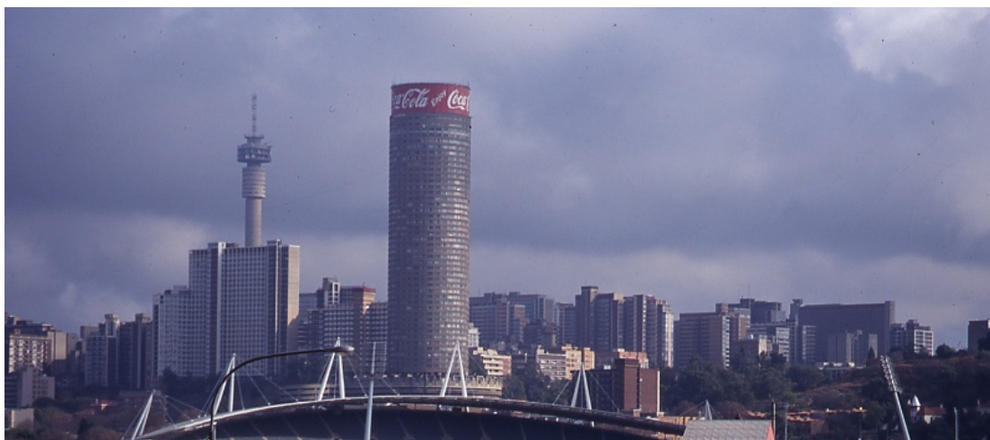
Figure 2-31 - Photographie de la Tour Ponte dont une exo-structure métallique haute de 6 étages a supporté, entre 1995 et 2000, une enseigne publicitaire de la marque Coca-Cola. Source : LINDSAY Bremner, 2013, « Buildings are geological agents », in Ponte City (sous la dir. Mikhael Subotsky et Ivan Vladislavic), Steidl, Göttingen. Consultable en ligne : https://geoarchitecture.wordpress.com/2014/01/16/buildings-are-geological-agents/ [Consulté le 23 septembre 2017]
