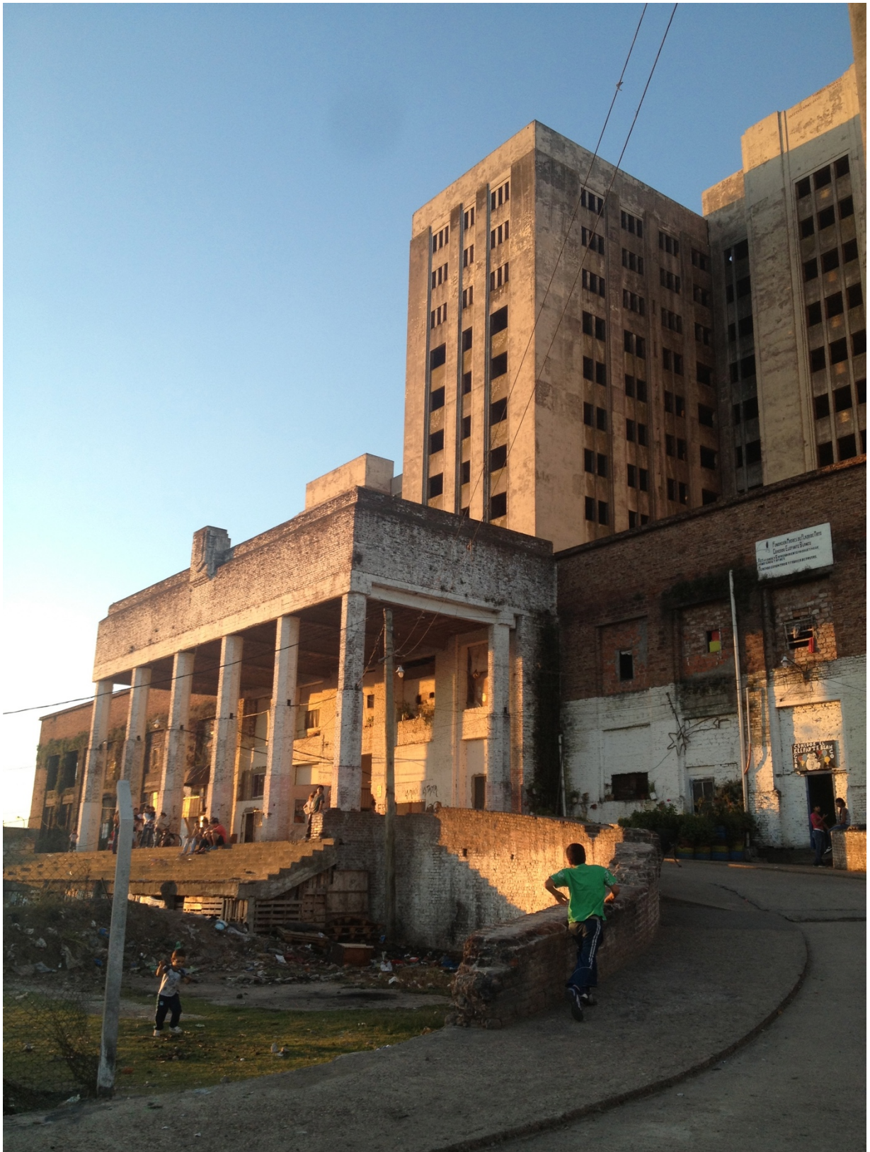
Figure 0-1 - Photographie prise à partir de la rampe d'accès de El Elefante Blanco. Source : auteur, mars 2013
