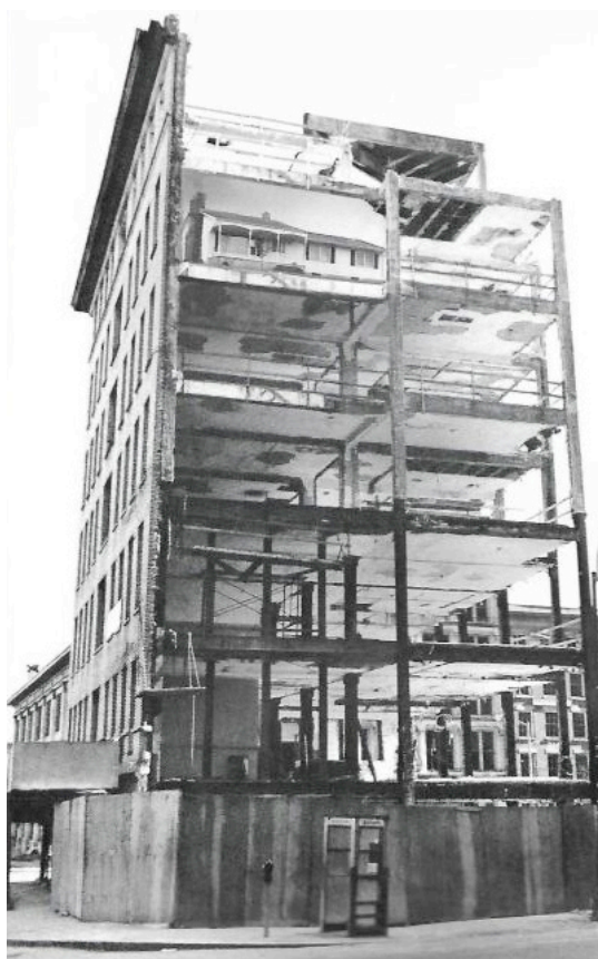
Figure 6-40 - Photographie d'un immeuble existant, partiellement démoli, laissant apparaître son ossature porteuse. Sur le dernier niveau, un collage a été réalisé, incluant une maison indépendante sur le plateau nu de la structure. Ce document montre d'utilisation d'une GSA pour mettre en œuvre le scénario du Highrise of Homes . Source : SITE, 1982, Highrise of Homes , Rizzoli, New York, p. 103
