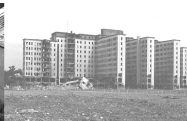
Structure : El Albergue Warnes Début du chantier : 1951 Crédit : Archivo di film Argentina, 1991
