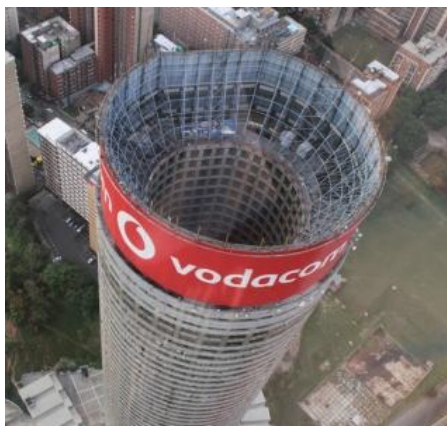
Figure 6-19 - Photographie aérienne de la Tour Ponte de Johannesburg (Spécimen #026) montrant la couronne publicitaire ajoutée en son sommet. Source : Ryjozi, 2012
