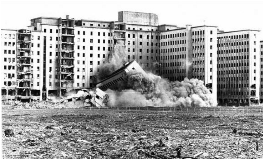
Figure 6-46 - Photographie prise le 16 mars 1991 alors que débute la démolition du Albergue Warnes . Source : Journal La Nación , 1991
