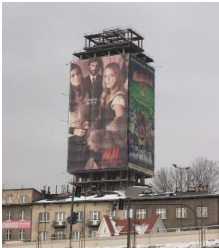
Figure 6-15 - Photographie de la structure de Cracovie, connue sous le nom de Szkieletor (Spécimen #044). Des panneaux publicitaires sont disposés sur 2 de ses 4 façades. Source : CreativeCommons, 2009
