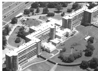
Structure : Hôpital Posadas Début du chantier : Crédit : Journal Sanidad, 2015
