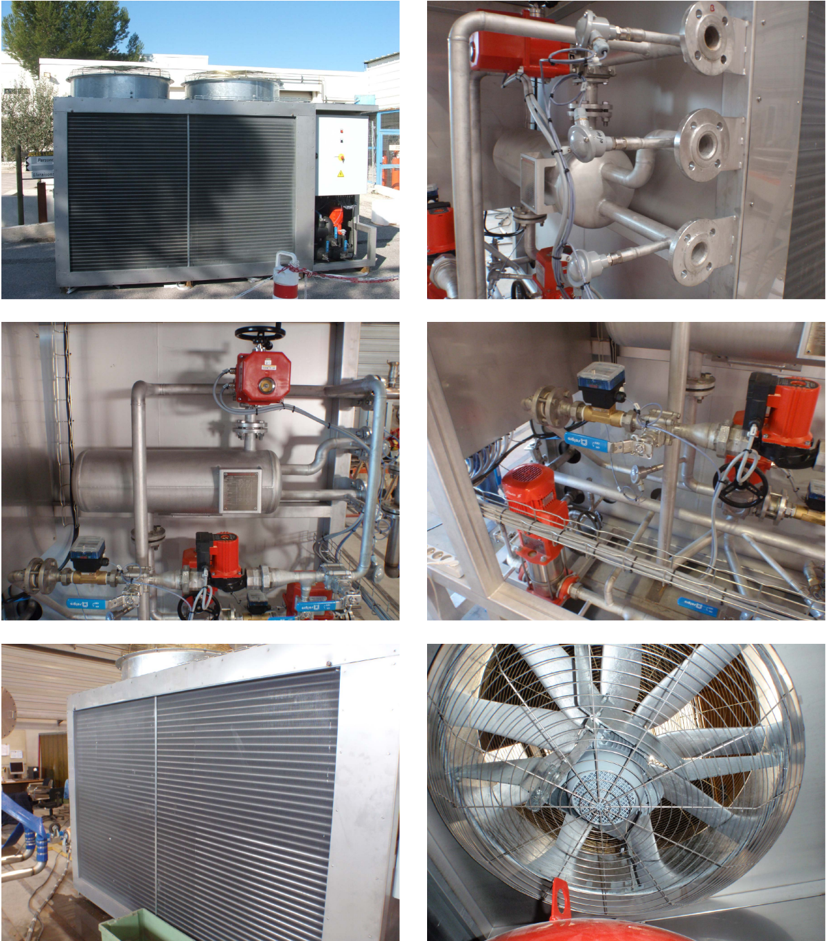
FIGURE H.1 – Photographies complémentaires du sous-système de gestion de la chaleur. De gauche à droite et de haut en bas : (a) Vue générale (b) Brides de raccordement aux procédés et au circuit de valorisation (c) Échangeur de chaleur plaques-calandre (d) Pompe de circulation (e) Serpentin de refroidissement (f) Ventilo-convecteur
