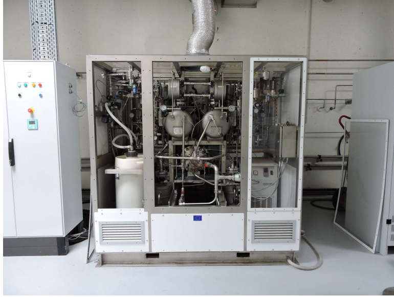
FIGURE 2.2 – Photographie du sous-système électrolyseur
