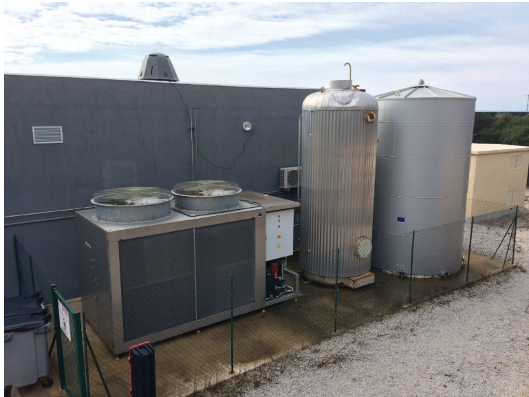
FIGURE 3.1 – Photographie du sous-système de gestion de la chaleur
