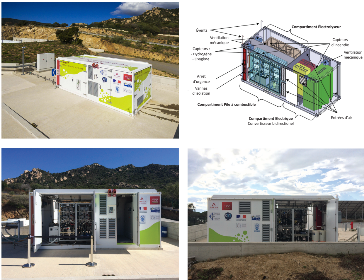
FIGURE 2.20 – Photographies du Sous-Système GreEnergyBox. (a) Vue générale (b) Maquette 3D [209] (c) Vue du côté pile à combustible (d) Vue du côté électrolyseur
