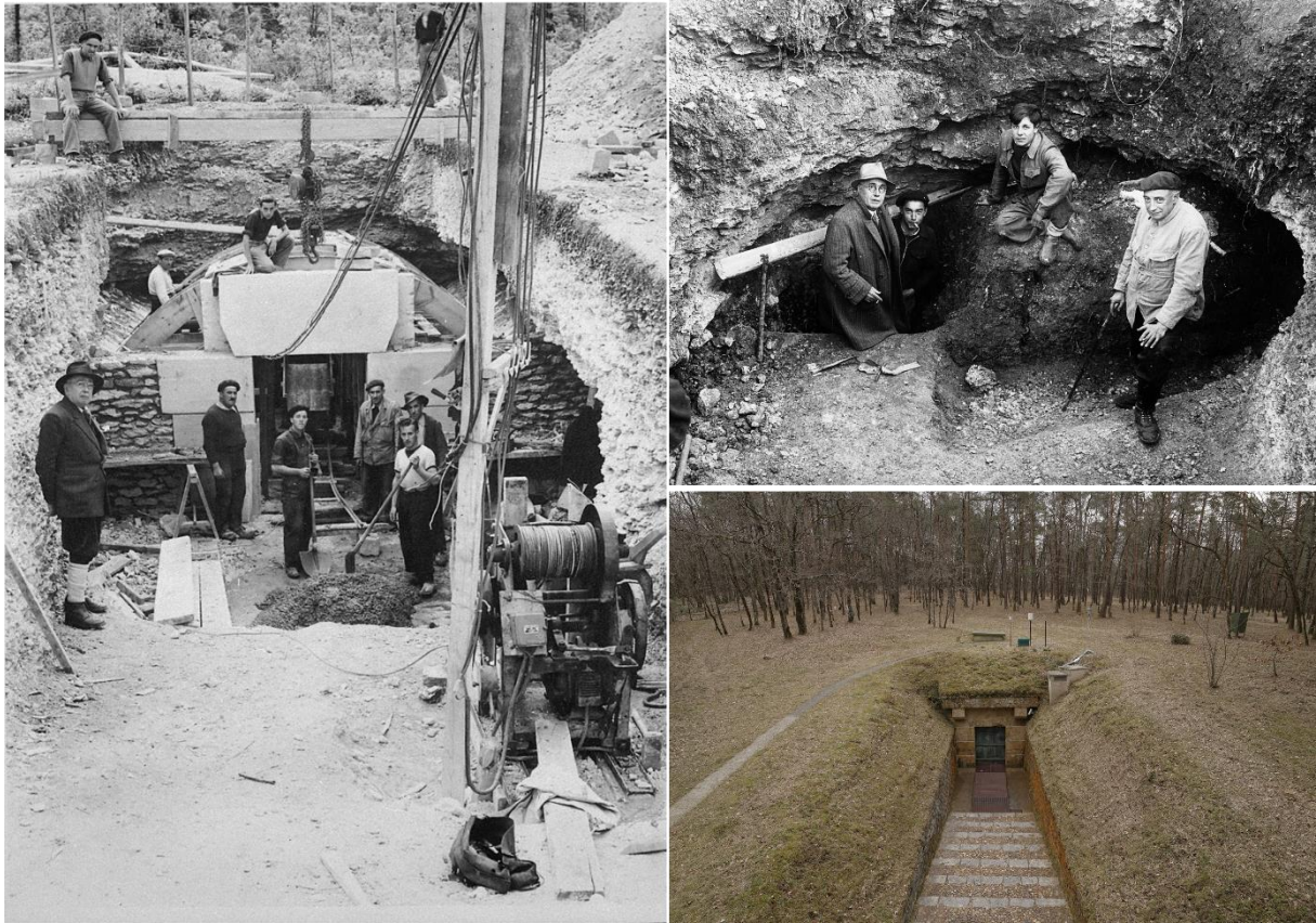
Figure 159 : Évolution de l'entrée : Premier agrandissement en 1940 (photographie en haut à droite ; Ph. M. Larivière/CNP), Travaux d'aménagement pour l'accueil du public en 1947 (photographie de gauche ; © D.R.), et état actuel de l'entrée (photographie en bas à droite : O. Huard/Centre National de la Préhistoire/Ministère de la Culture).
