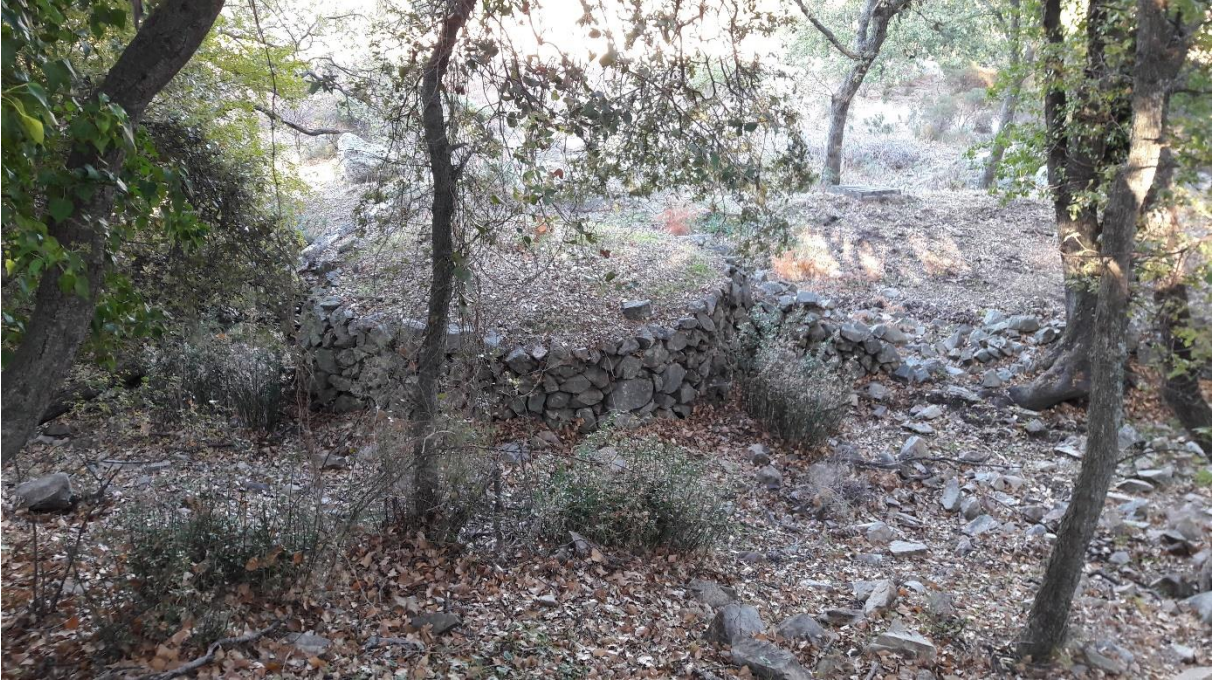
Dos du bâti dans un mur au nord-est du site (cl. J. Graziani, 2017)
