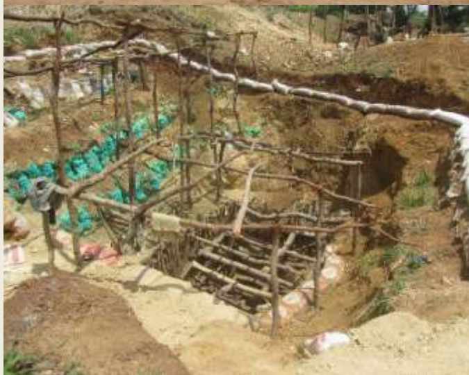
d. Soutènement de puits de tranchée aurifère de type Hong Kong et construction de hangar dans le site de Maména.
