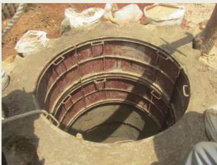
e. Début de bétonnage à Maména. Une nouvelle méthode de protection des puits d'orpillage.
