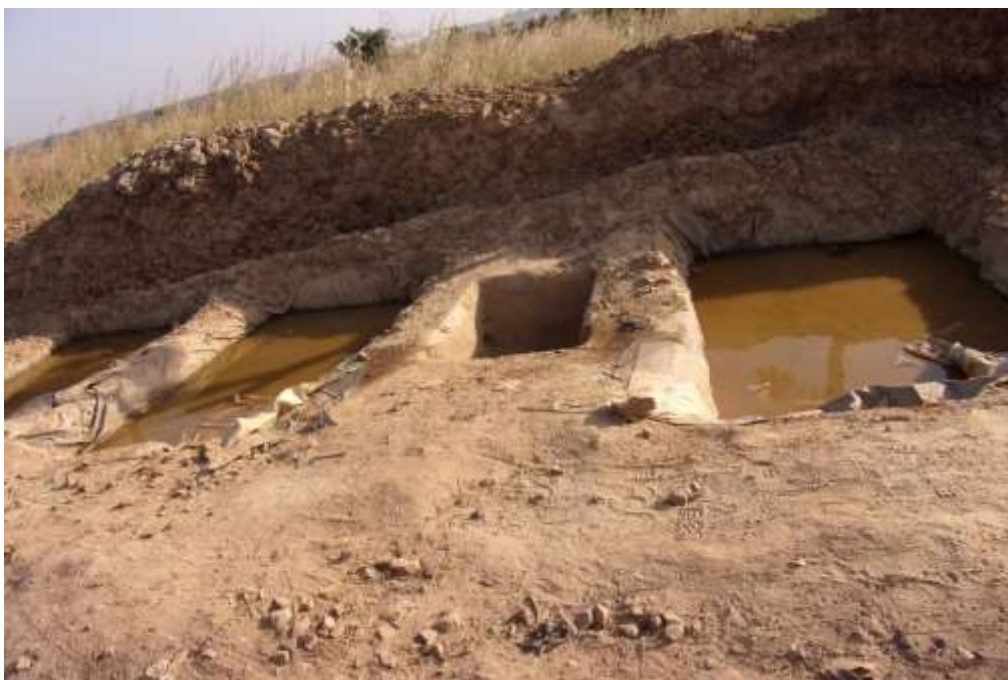
Photo 11 : dispositif de cyanuration du minerai à Fofora
