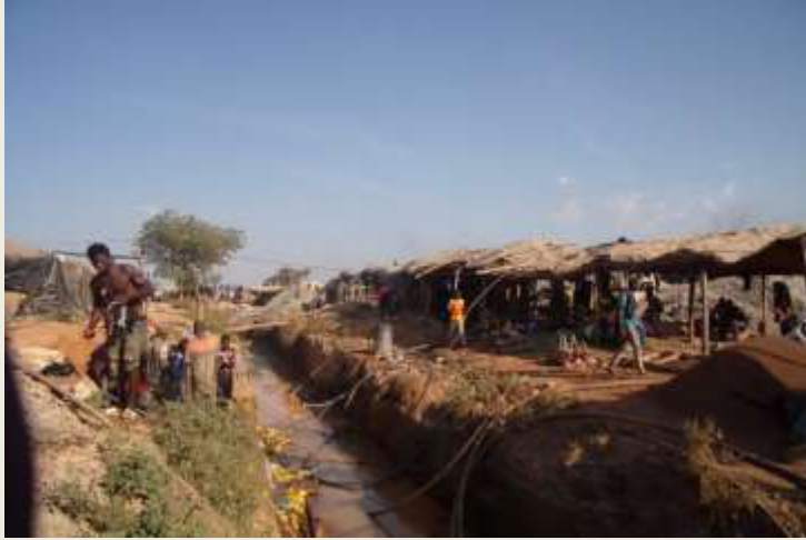
d. Canal construit par les orpailleurs pour l'évacuation des eaux d'exhaure du site de Sangboulanti
