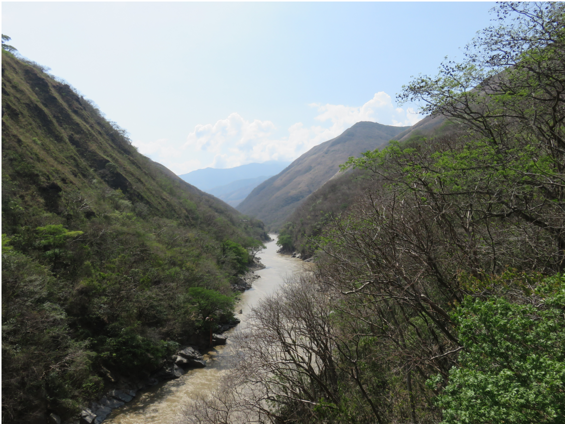
Photo 3: Couverture de BST sur les versants du canyon, municipe de Ituango (auteur : Benassaya, 2016)
