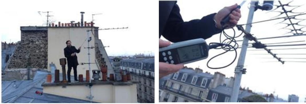
Figure 192 Figure 191. Installation de l'anémomètre sur le toit du bâtiment 136 avenue Parmentier, Paris 11ème. Une antenne de TV a servi de support de fixation du dispositif.
