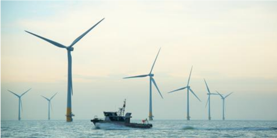
Figure 22. Ferme éolienne offshore de Kentish Flats, au large des côtes britanniques du Kent (©Vattenfall-Robin Dawe)
