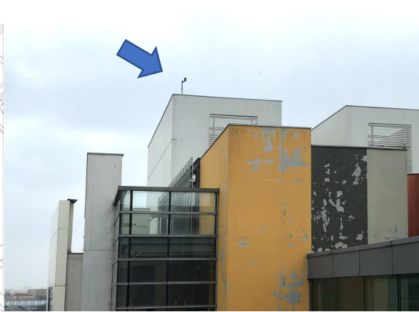
Figure 101. Vue du dispositif inséré sur le toit du bâtiment
