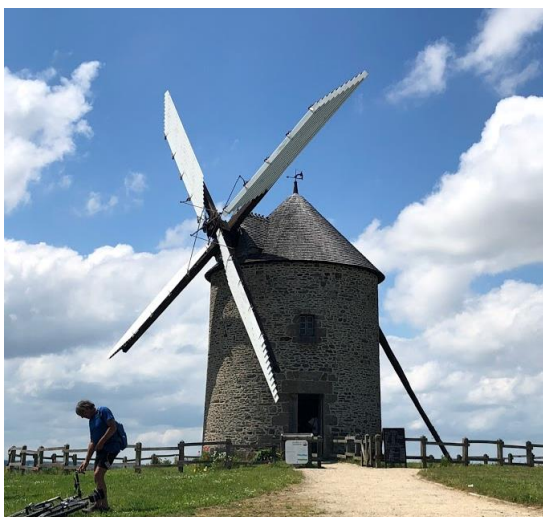
Figure 10. Le moulin de Moidrey à Pontorson (Manche), Photographie D. Serero le 27 mai 2018, c'est un moulin de type « moulin tour »
