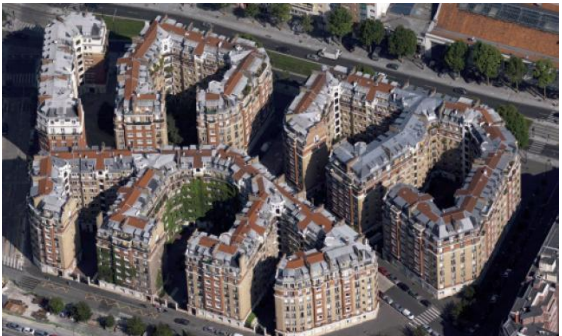
Figure 54. Immeuble de logement type I.L.M., 1924-1926 boulevard Jourdan, 14 e arrondissement. ( https://www.apur.org/fr )
