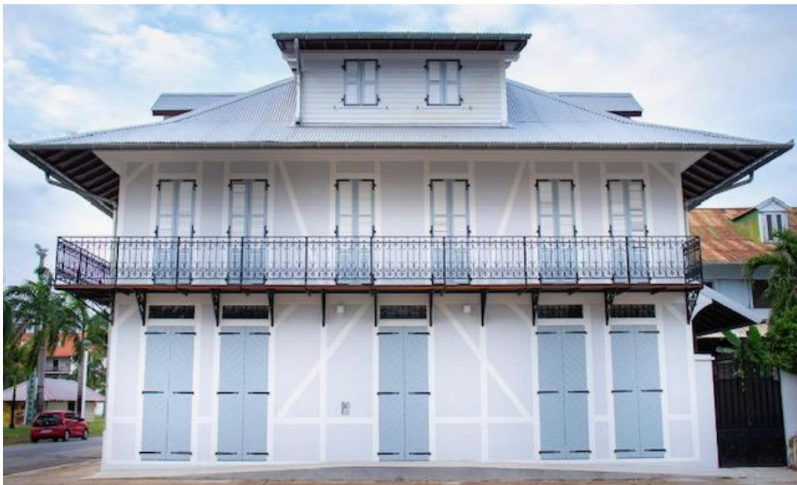
Figure 15 : Maison créole réhabilitée à un étage
