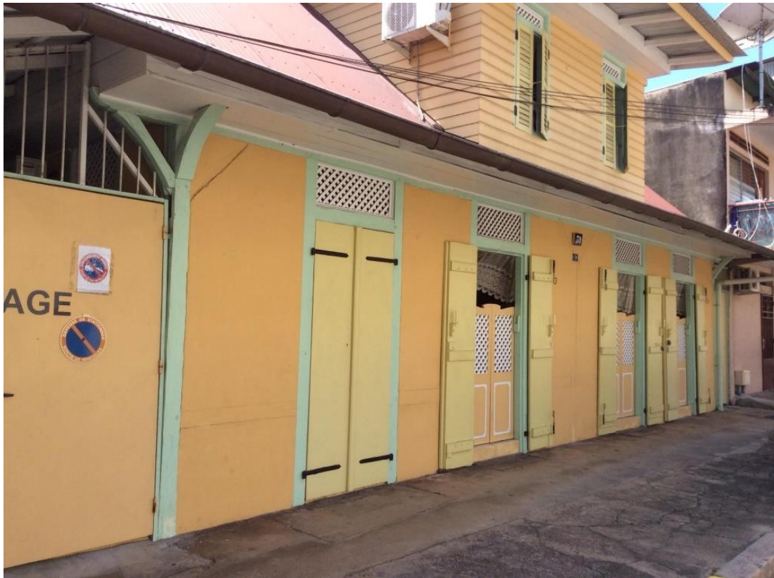
Figure 14 : Maison créole réhabilitée en rez-de-chaussée
