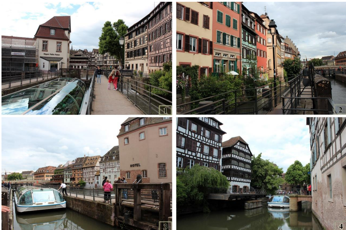
Figure 92. Prises de vue montrant (1,2,3,4) des ouvrages hydrauliques (ponts, écluses) conçus pour gérer la circulation (piétons et péniches) sur l'Ill dans la petite-France (©MOUAD, 2013).
