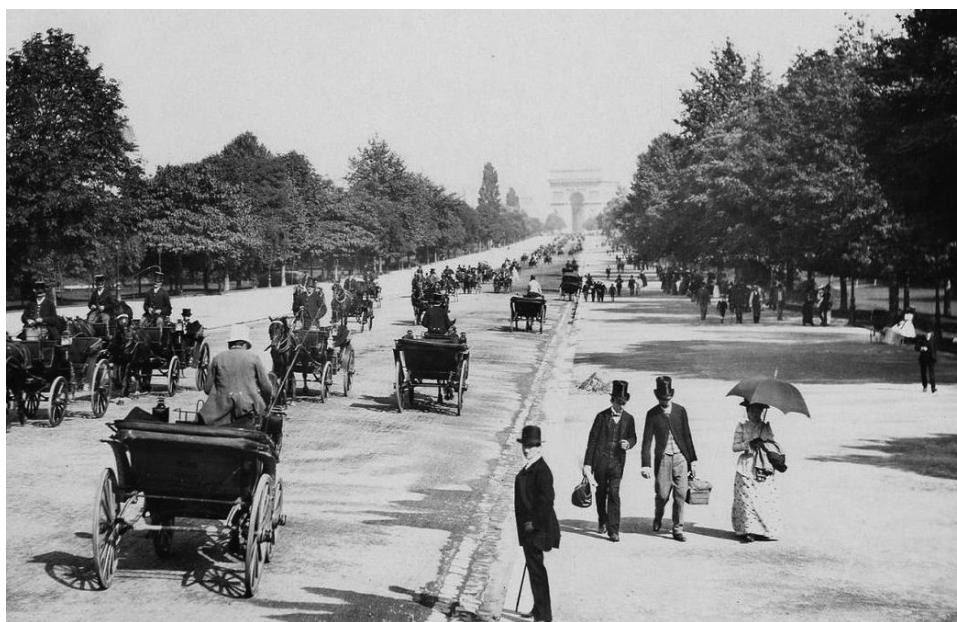
Figure 4. Avenue de l'Impératrice (l'actuel Avenue Foch) ; on note l'axe central pour la circulation mobile et deux larges trottoirs aménagés pour la promenade (©BNF, vers 1900).
