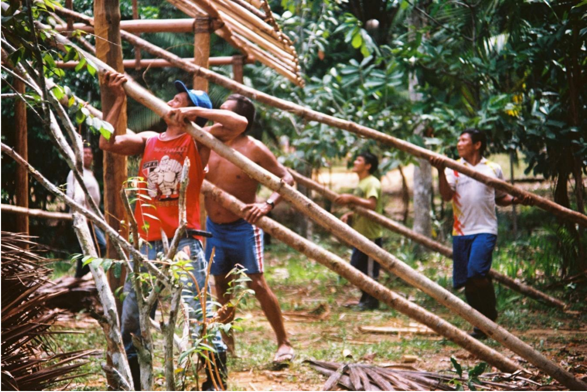
Photo 38 : les hommes montent la charpente. ©Emmanuel Richard, 2017.
