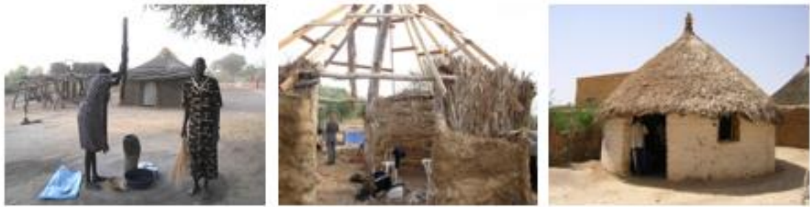
Figure 69 : Construction d'un tukul - maison traditionnelle soudanaise
