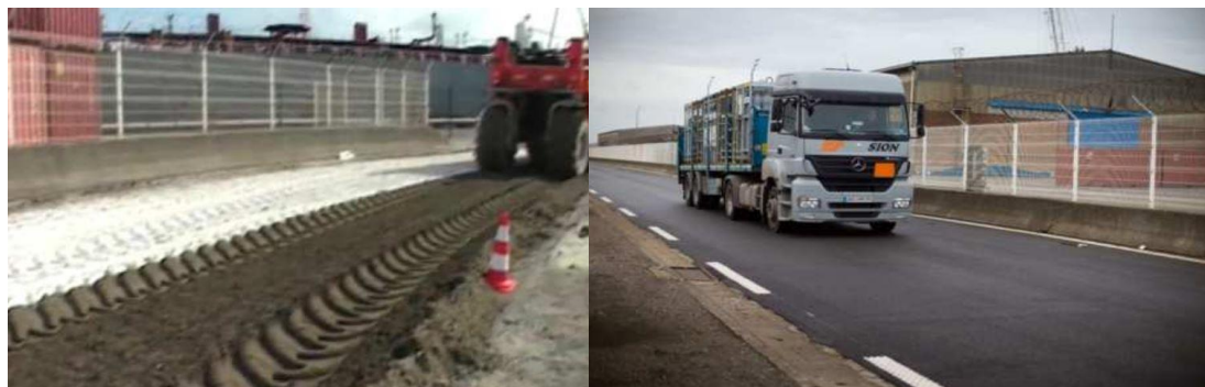
Figure I.4. Utilisation des sédiments de dragage dans la réalisation d'une route expérimentale [61].
