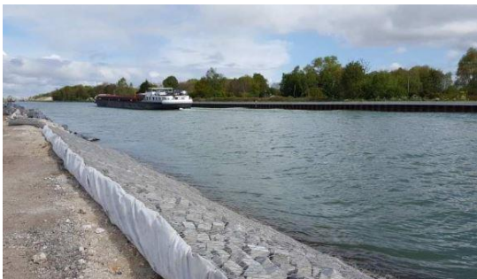
Figure I.6. Pierres artificielles de béton à base de sédiments [71].
