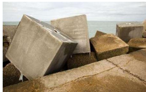
Figure I.7. Blocs de béton à base de sédiment utilisés dans la protection des côtes [72].
