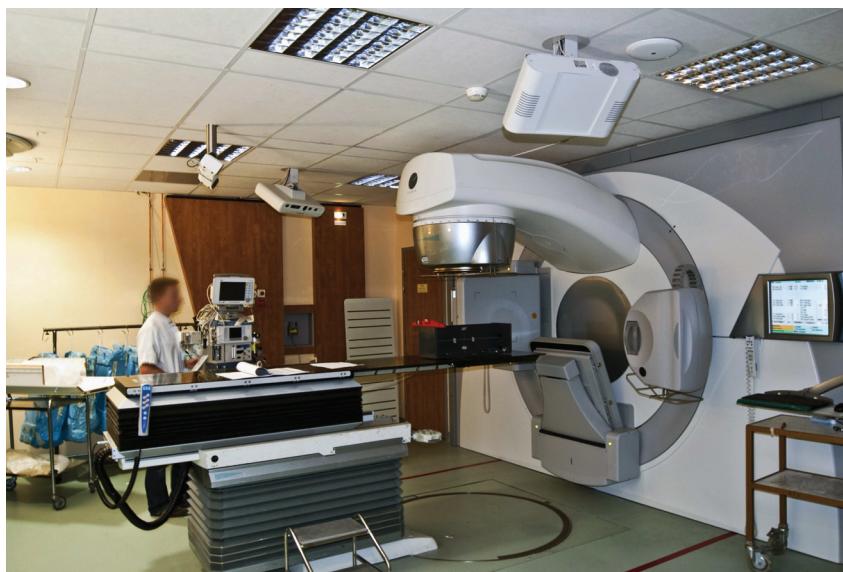
FIGURE 4.2: Exemple d'une salle de traitement en radiothérapie (Centre Léon Bérard [7]).
