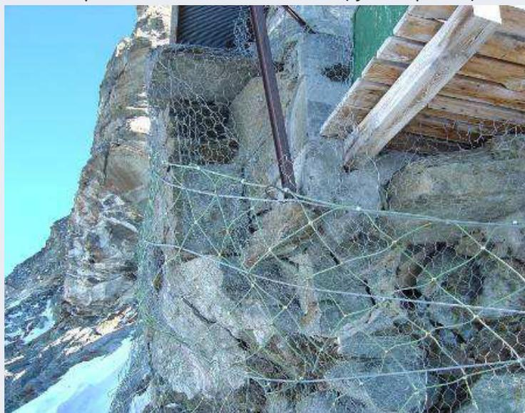
**Figure 7.6.** Installation de filets et rénovation des fondations du refuge Carrel (3835 m, Italie ; Vuillemier, 2014).
