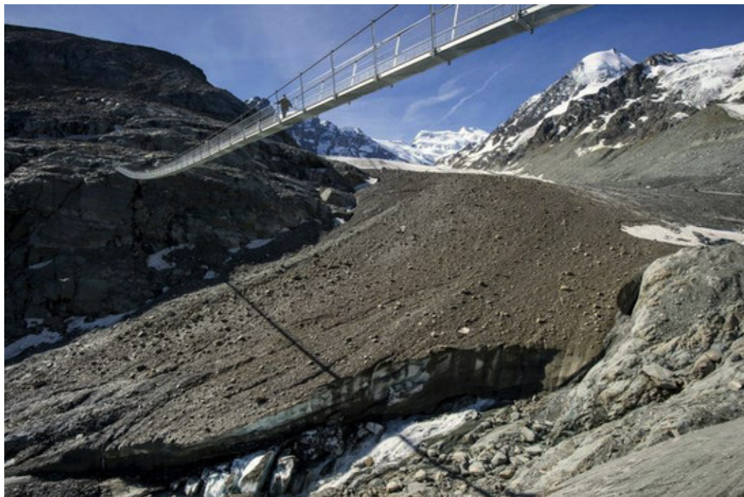
Figure 4.4. Passerelle de Corbassière (longueur : 290 m ; hauteur : 70 m) pour l'accès au refuge de Panossière (Valais, Suisse). Coût : 400 000 CHF. (ph. coll@Hoffmann, 2014).
