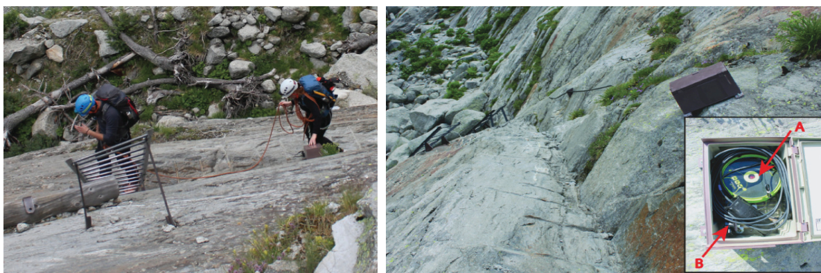
Figure 2 - Capteur Pyro sur l'accès à la Mer de Glace depuis le Montenvers. À droite : boîtier en plastique dans lequel l'Eco-Combo (a) et le capteur Pyro (b) ont été installés. Le boîtier constitue une protection efficace contre le soleil et le vandalisme.
