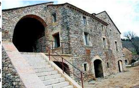
La ferme de Fretma (Causse Méjean) après restauration
