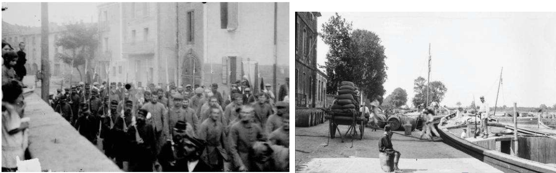
Figure 51. Prisonniers allemands. 1. Colonne en route vers la caserne Mirabel. 2. Déchargement de péniche à la halte du Canal du Midi. 1344
