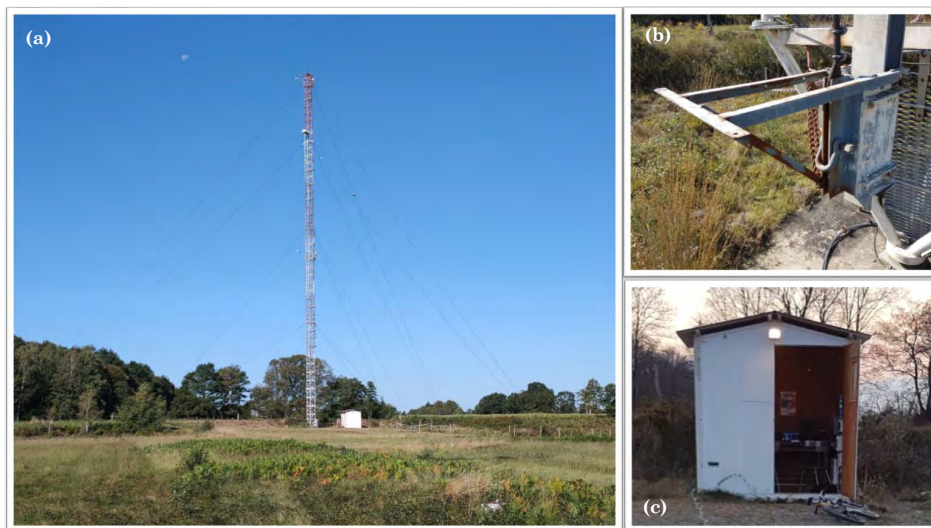
Figure 4.2 – (a) Mât météorologique de 60 mètres instrumenté à plusieurs niveaux avec des capteurs de pression atmosphérique, de température de l'air et des profileurs de vent. (b) Plateforme élévatrice accrochée à la tour. (c) À proximité immédiate de la tour, une cabane accueillant l'ensemble de l'architecture informatique d'acquisition nécessaire au fonctionnement des instruments est présente. Les câbles d'ancrage dans le sol sont facilement identifiables sur la photographie.
