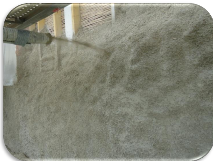
Figure I-49. Béton de chanvre projeté 2
