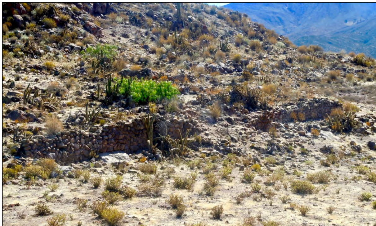
Figure 6.10: Vue du mur d'enceinte de T011-Paramarka détruit probablement suite à d'importants phénomènes climatiques.
