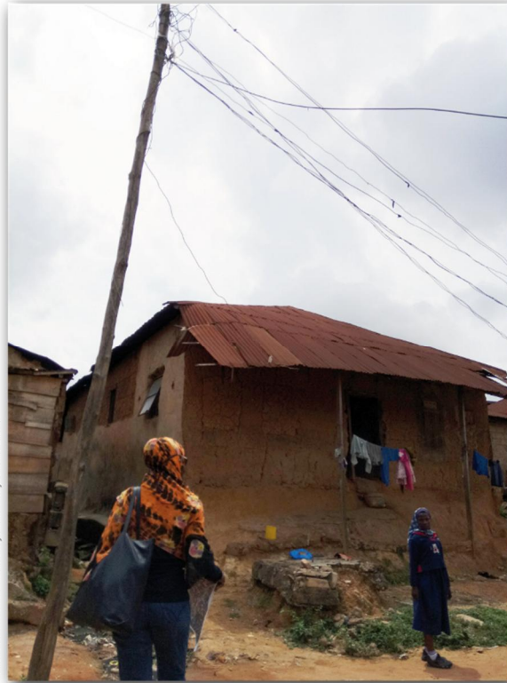
PHOTO 36 : POTEAU ÉLECTRIQUE COMMUNAUTAIRE DU RÉSEAU RAFISTOLÉ D'OJE
