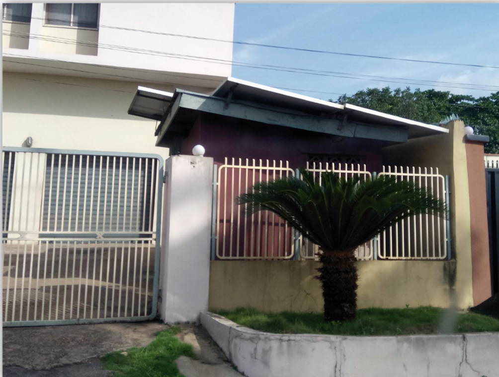
PHOTO 59 : ABRI DU GROUPE ÉLECTROGÈNE RECOUVERT DE PANNEAUX SOLAIRES
