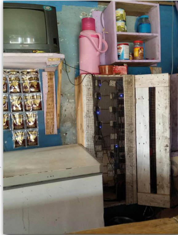
PHOTO 49 : ARMOIRE DE RECHARGE DE BATTERIES ET TÉLÉPHONES PORTABLES DANS UNE BOUTIQUE
