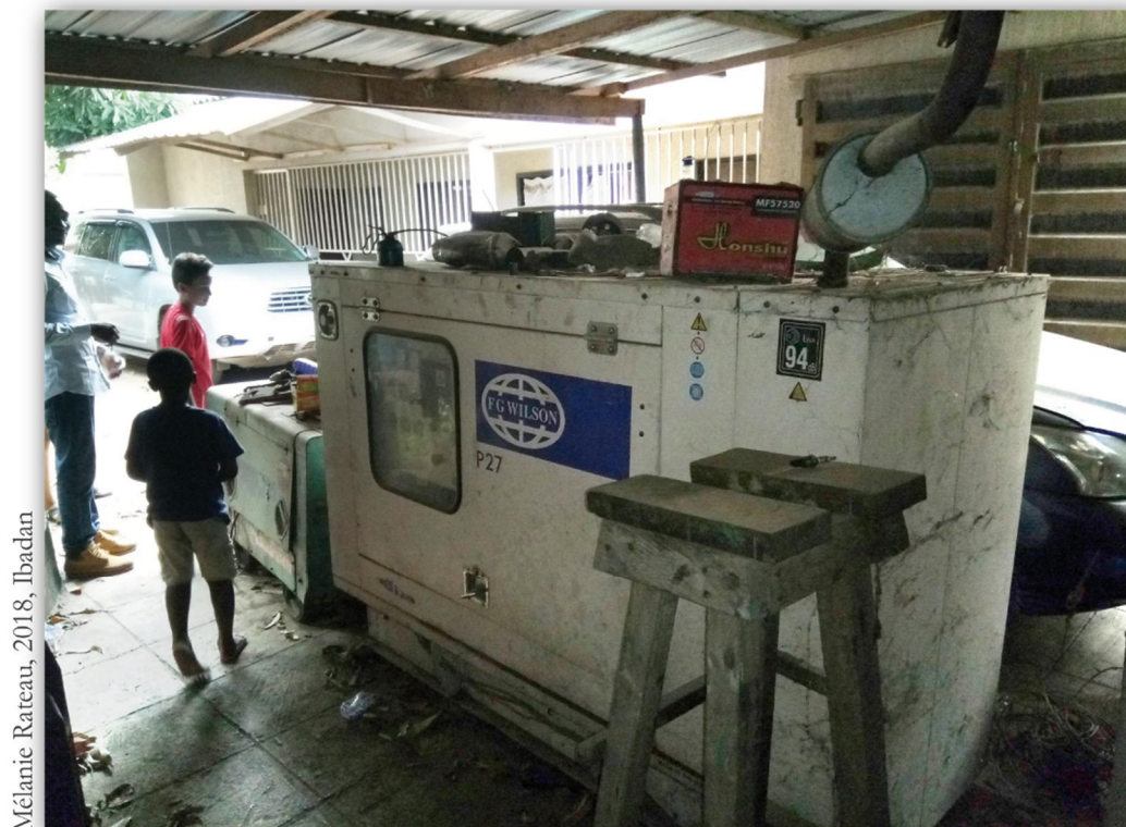
PHOTO 57 : DEUX GROUPES ÉLECTROGÈNES COMPLÉMENTAIRES POUR PRENDRE LE RELAIS DU RÉSEAU
