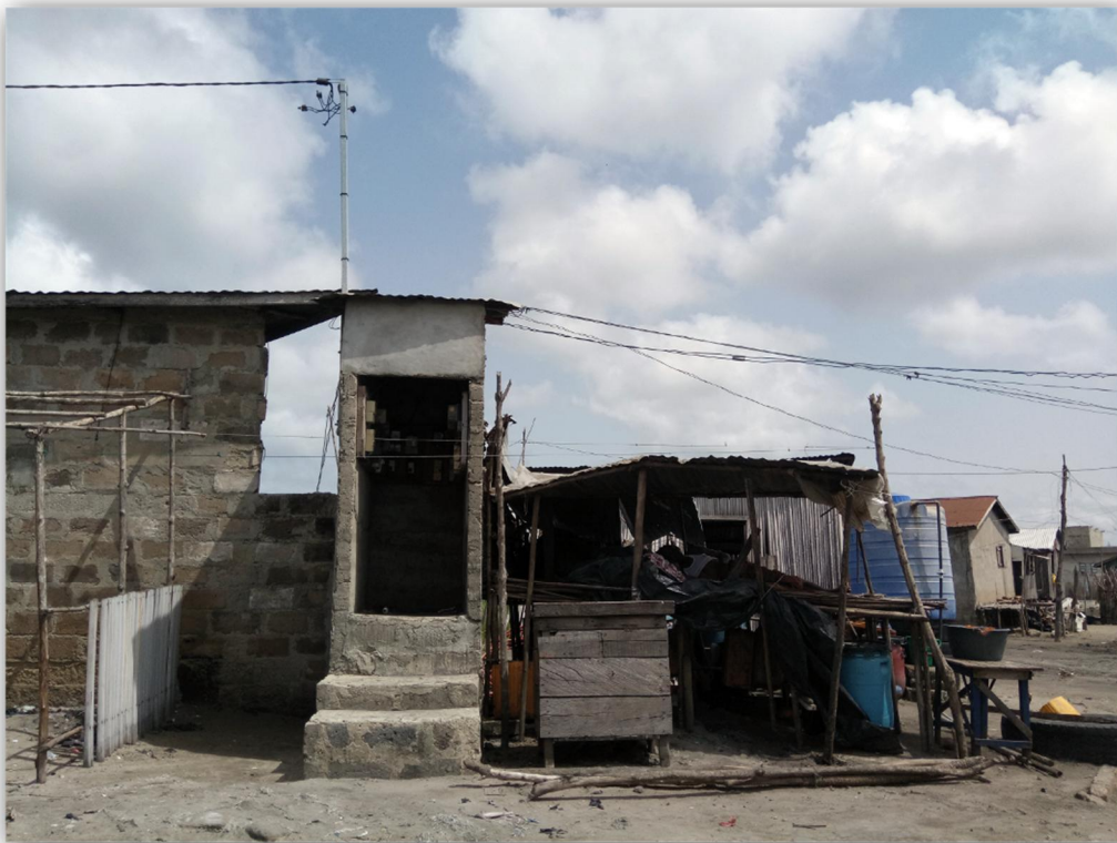
PHOTO 51 : CABANE À COMPTEURS VUE DE L'EXTÉRIEUR
