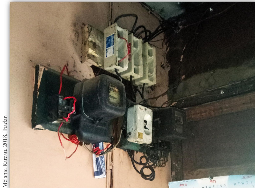
PHOTO 32 : FUSIBLES MANQUANTS ET REMPLACÉS PAR DES CÂBLES RIGIDES ROUGE
