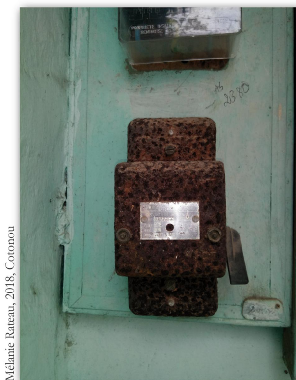
PHOTO 70 : DISJONCTEUR HORS D'ÂGE MAIS TOUJOURS EN FONCTIONNEMENT
