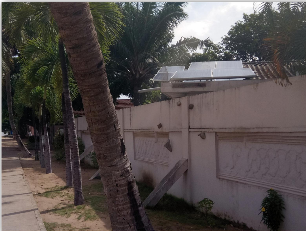
PHOTO 71 : DIX PANNEAUX SOLAIRES PHOTOVOLTAÏQUES DOMESTIQUES
