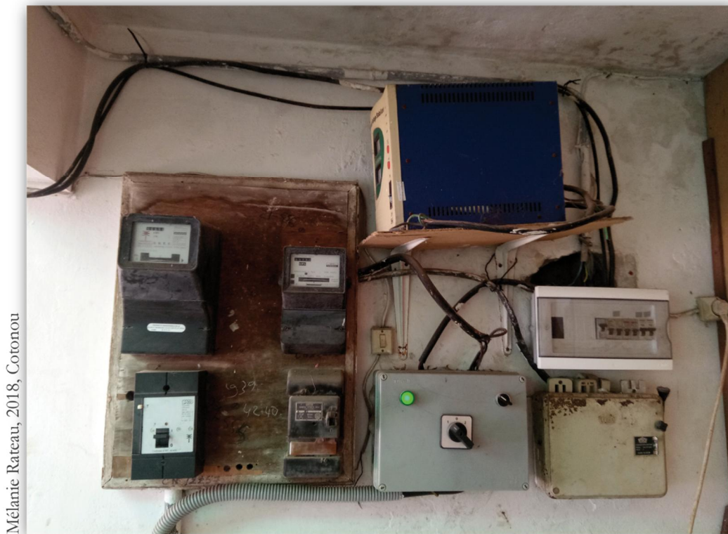
PHOTO 69 : STABILISATEUR DE TENSION INSTALLÉ EN AVAL DES COMPTEURS ÉLECTRIQUES
