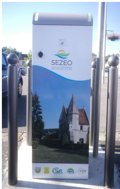
Figure 42 : Borne de recharge installée par le SEZEO représentant le Château du roi Jean à Béthisy-Saint-Pierre (Oise).
