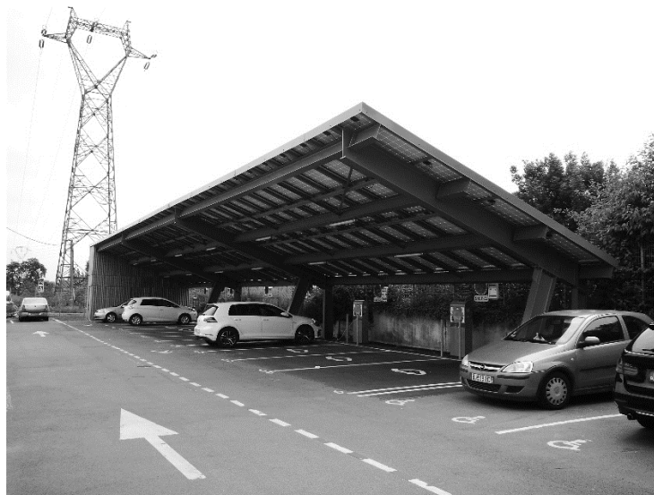
Figure 62 : Ombrière photovoltaïque à Lomme.
