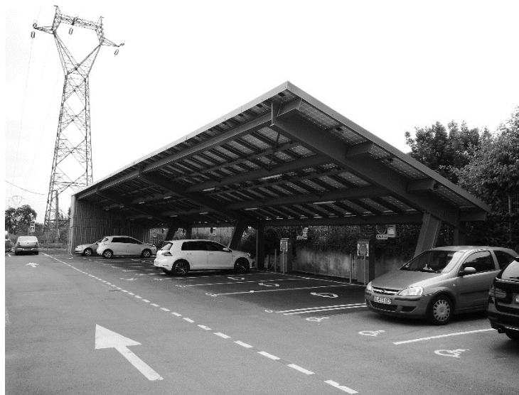
Figure 62 : Ombrière photovoltaïque à Lomme.
