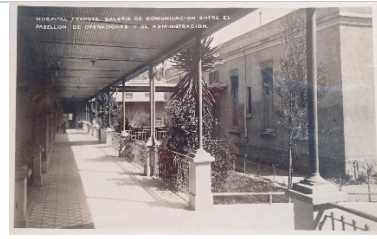
Anonyme, galerie entre le pavillon de chirurgie et l'administration [vers 1921], cote : 2016.10.15_2c, fonds Macon, MDLV© Ici nous voyons le système constructif d'une galerie : poteaux et poutres en fer, mais plancher en béton armé, recouvert de bois.
