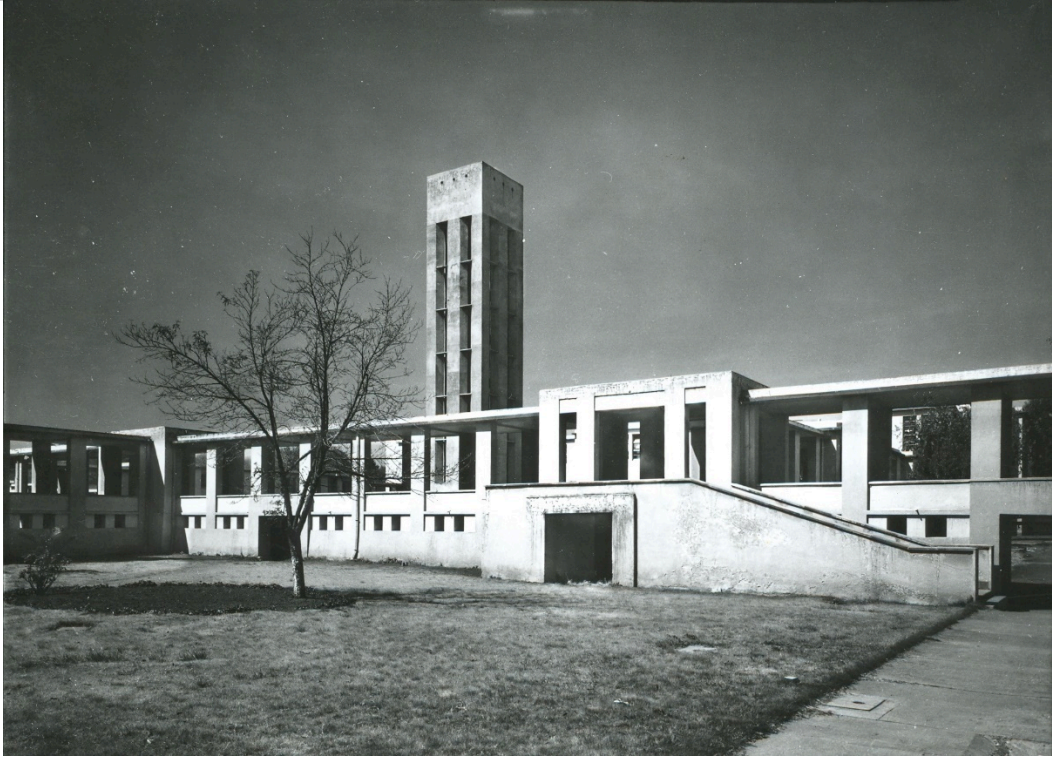
Vue du système de galeries à double niveau et du château d'eau au second plan, DACPAI INBA.
