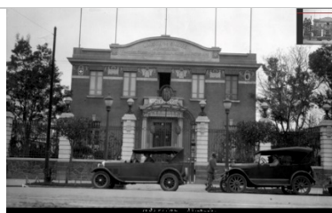
A.Casasola, façade principale du bâtiment administratif, 1925, col. Casasola, cote : 77_20140827-134500:3872, Mediateca INAH.
