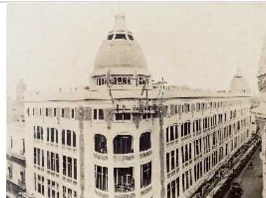
F. Marcon, construction de la façade [1921], fonds Marcon, cote : 2016.10.15_2c, MDLV.
