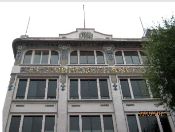
A.M. Porraz Castillo, détail supérieur de la façade de l'ancien magasin El Correo Francés , 2017 Detail porte
