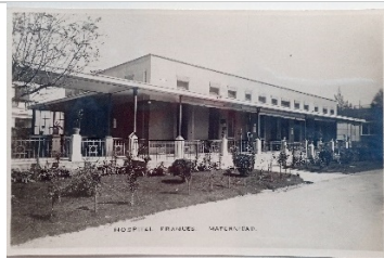
Anonyme, deuxième étape de l'hôpital : la maternité, [vers 1921], cote : 2016.10.15_2c, fonds Macon, MDLV© Ici nous découvrons le système constructif des passerelles : poteaux et poutres en fer, mais planchers en béton armé.
