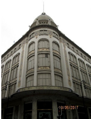
Détail de l'un des accès en rotonde d'angle, 2017, AMPC.
