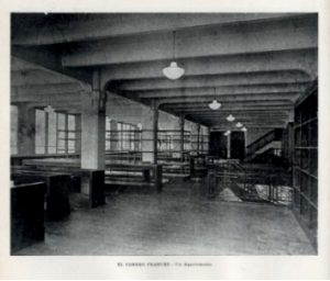
Vue intérieure du Correo Francés , revue Cemento , n. 19, 1927
