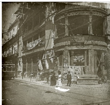
Vue de l'accès en rotonde vers 1910, 2016.10.15_1c, fonds Marcon, MDLV.
