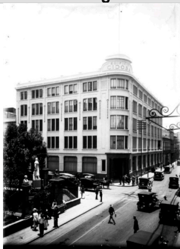
A. Casasola, vue générale du bâtiment CIDOSA, 1930, col. Casasola, cote : 77_20140827-134500:824706, Mediateca INAH©
