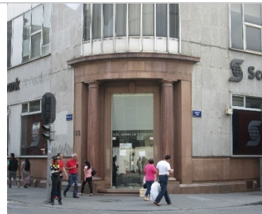
Vue de l'accès. Le marbre y est conservé, 2020, AMPC.
