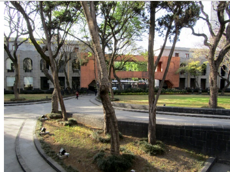
Vue du pont entre le bâtiment de l'administration générale et les deux ailes des bureaux, 2020, C. Gutiérrez Silveira.
