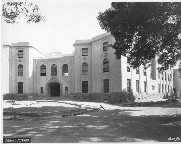
G. Kalho, vue de la façade principale (chantier), 1928, DACPAI INBA.
