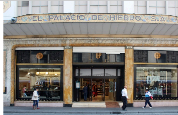
Vue de l'accès sur la rue 5 de febrero en 2020, issu de la cinquième intervention en 1928, le chantier était à la charge de l'ingénieur Miguel Rebolledo, Probable engagement de l'agence Dubois-Marcon pour la conception, AMPC.
