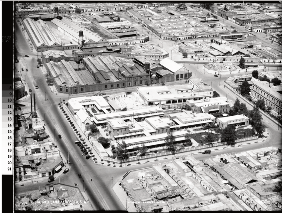
Anonyme, vue aérienne de l' Hospital francés à México en 1932, cote : FAO_01_000413, fundación ICA© Sur cette vue aérienne nous voyons les agrandissements qui sont achevés en 1921 : ajout de salles d'opération, construction des laboratoires, de la maternité, etc.
