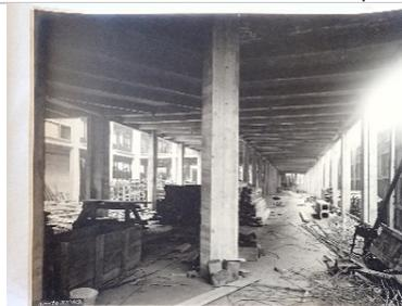
F. Marcon, construction intérieure (poutres et colonnes en béton armé), cote : 2016.10.15\_2c, fonds Marcon, MDLV.
