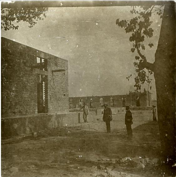
F. Marcon, vue de la construction de la première étape de *l'Hospital francés* vers 1911, 2016.10.15\_1b, fonds Macon, MDLV© Sur cette photographie du chantier, nous apercevons les pavillons surélevés d'un mètre, ainsi que les grandes ouvertures des fenêtres.
