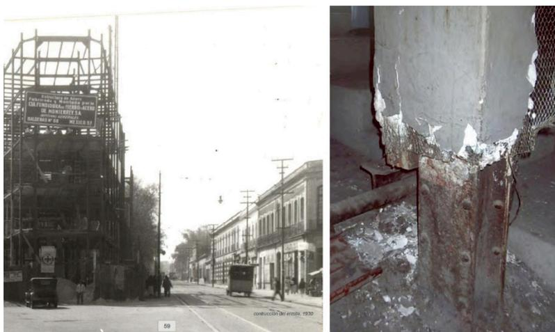
Figure 277. À gauche, façade en construction du bâtiment *Ermita*, structure à la charge de la société de construction *Fundidora Monterrey* ; à droite, un détail des colonnes en acier lors d'une prospection en 2006, tirées de F. Marín Zamora (2006).
