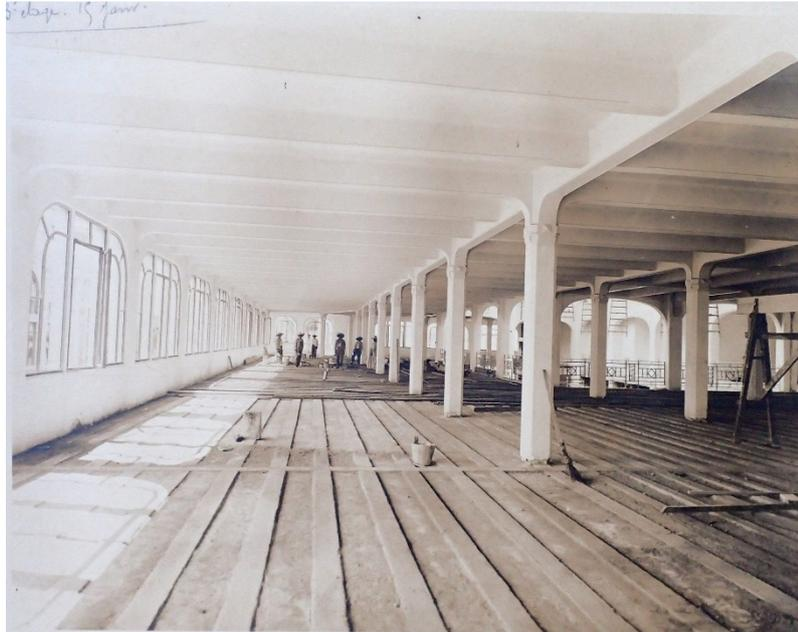
Figure 273. F. Marcon, autre vue du chantier de la reconstruction en béton armé du magasin El palacio de Hierro en 1919 et 1920, 2016.10.15\_2c, fonds Marcon, MDLV©.
