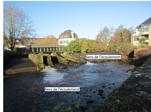
(b) Vue aval de l'ouvrage
