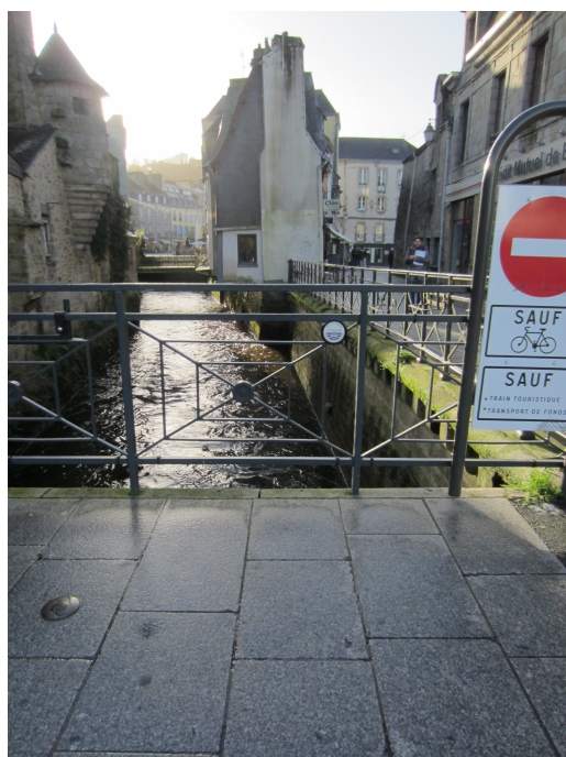
(a) Vue d'ensemble de la position du repère de crue
