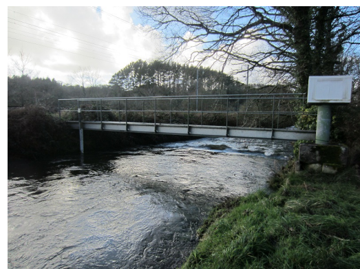
(b) Kerjean, vue vers l'aval. L'échelle est en rive gauche, la centrale d'acquisition est en rive droite.
