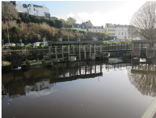
(a) Vue amont de l'ouvrage
