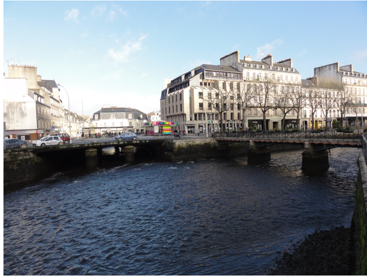
Figure 2.2: Confluence du Steir et de l'Odet dans le centre-ville de Quimper.
