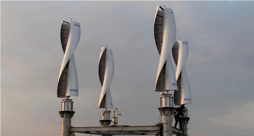
Figure 290. Eolienne de Savonius
