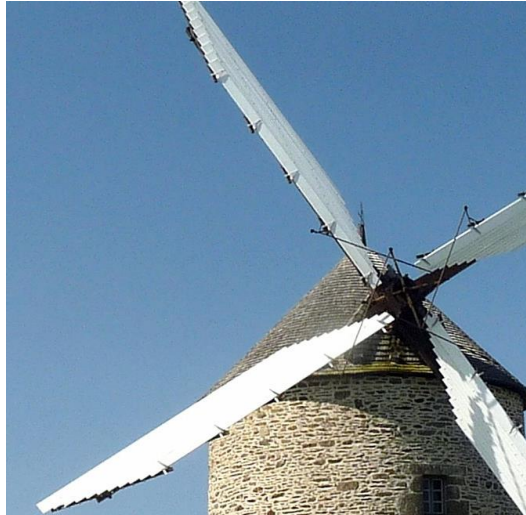
Figure 11. Détail des pâles dont l'angle peut varier en fonction de la vitesse du vent. ( D. Serero)
